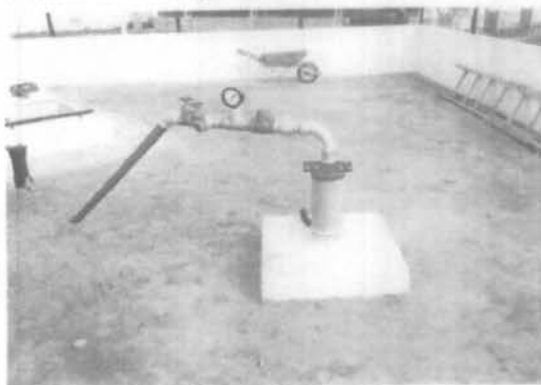
(Foto do poço Perfurado.)
