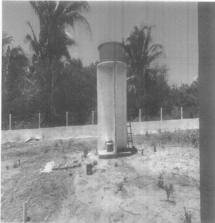
IMAGEM 5: BOMBA CENTRÍFUGA E FOSSA VERDE
