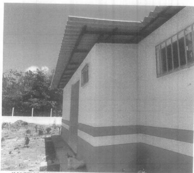
IMAGEM 2: ALVENARIA COM PINTURA, TELHADO FIBROCIMENTO
