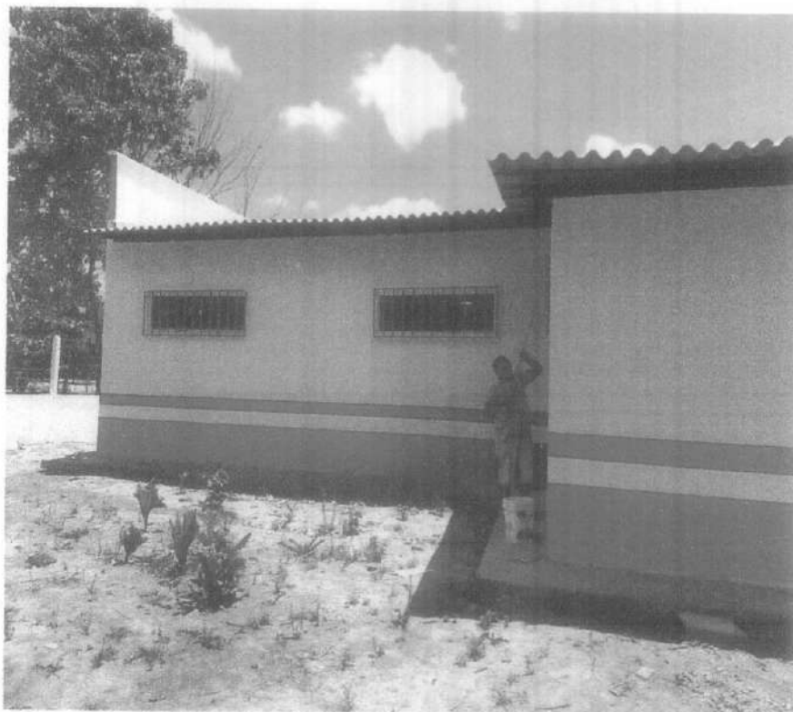
IMAGEM 3: PINTURA EM PAREDES EXTERNAS
