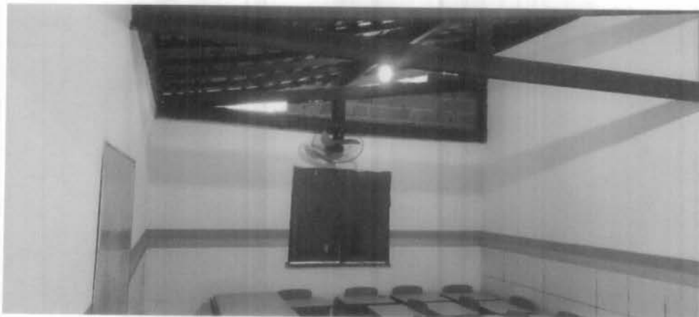
Imagem 03 – Sala de Aula 01
