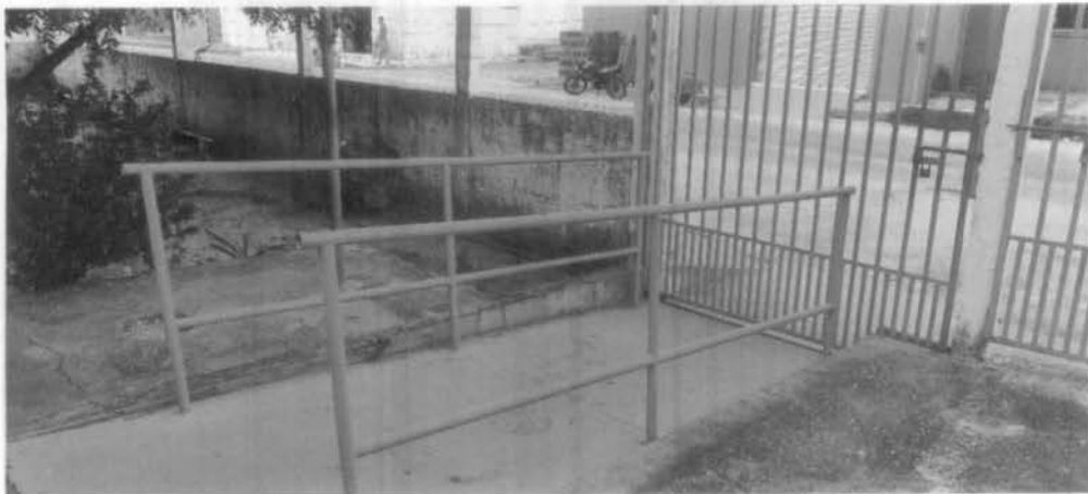
Imagem 10 – Rampa de acessibilidade
