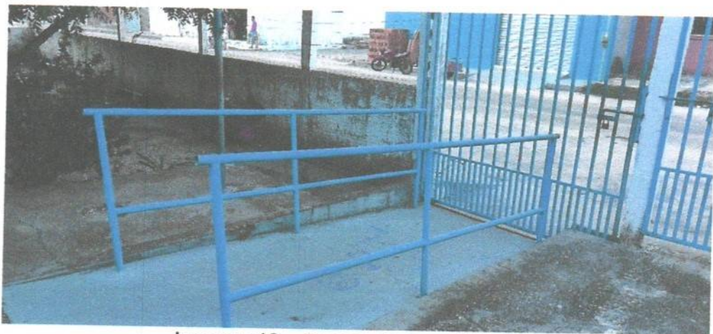
Imagem 10 – Rampa de acessibilidade
