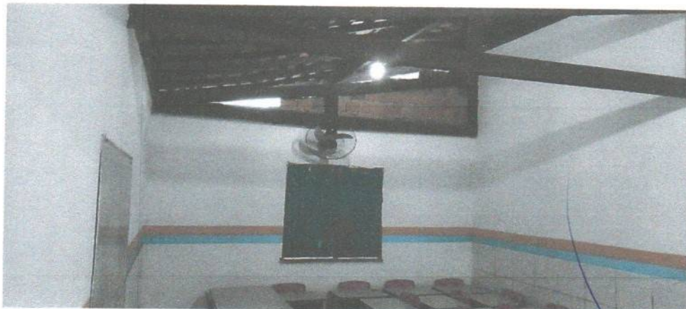
Imagem 03 – Sala de Aula 01
