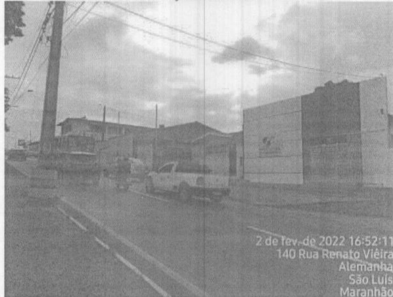
Vista Ampla da Rua Renato Viana e Localização da Sede.
