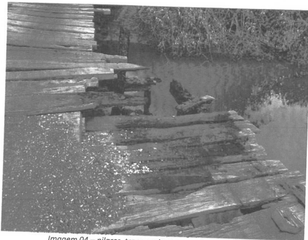
Imagem 04 – pilares, transversinas e pranchas queimados.
