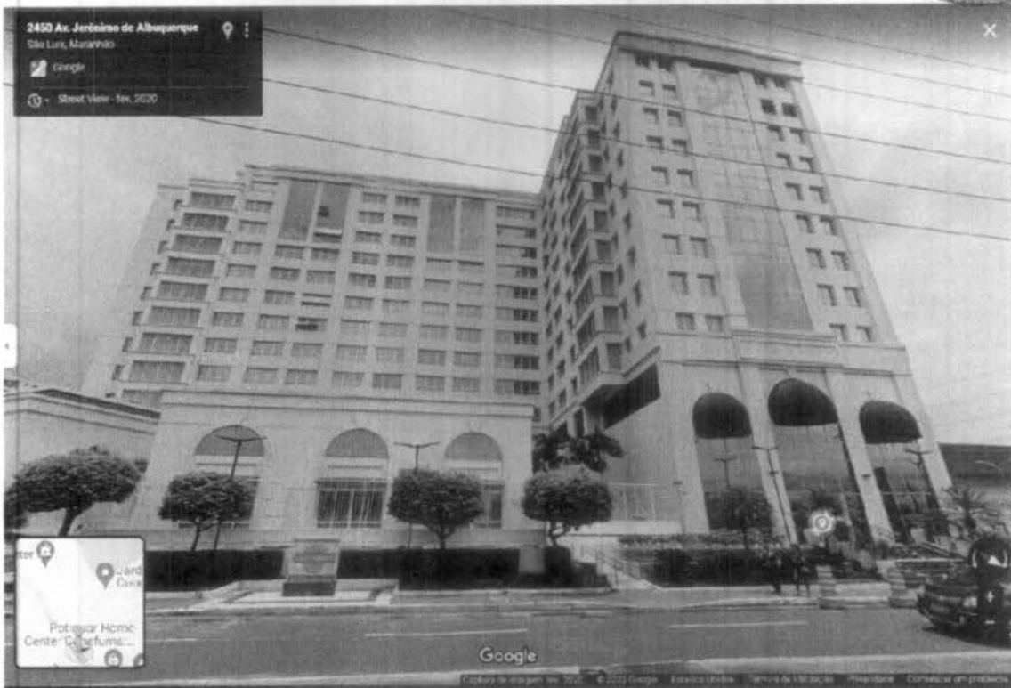
Fotografia da Fachada do Edifício
