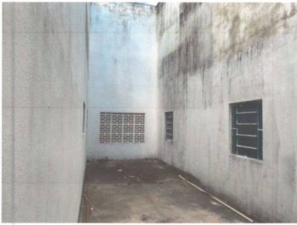
Imagem 7 – Área aberta e Entrada Ventilação
