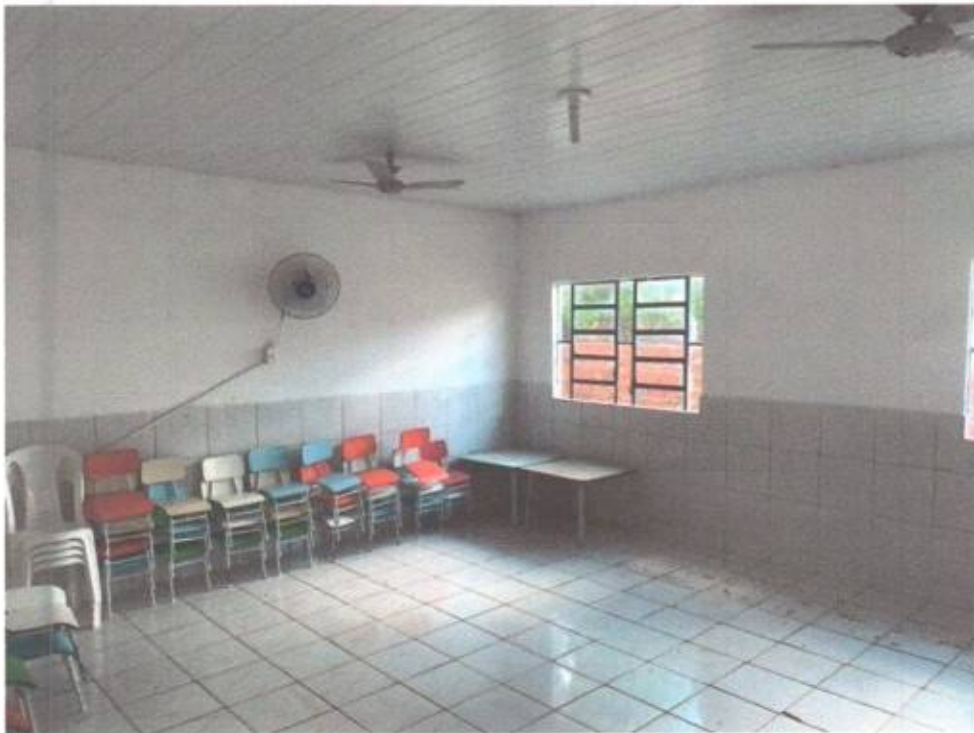
Imagem 14 – Sala de Aula
