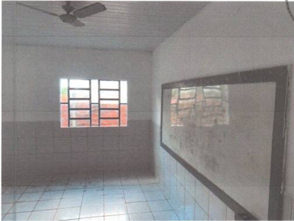
Imagem 13 – Sala de Aula
