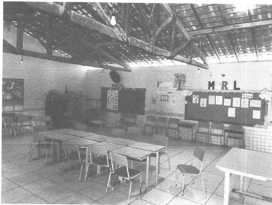
Figura 12: vista da sala de aula 03
