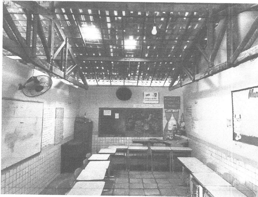
Figura 13: vista da sala de aula 04
