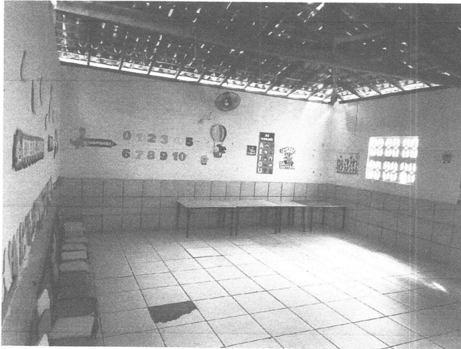
Figura 11: vista da sala de aula 02
