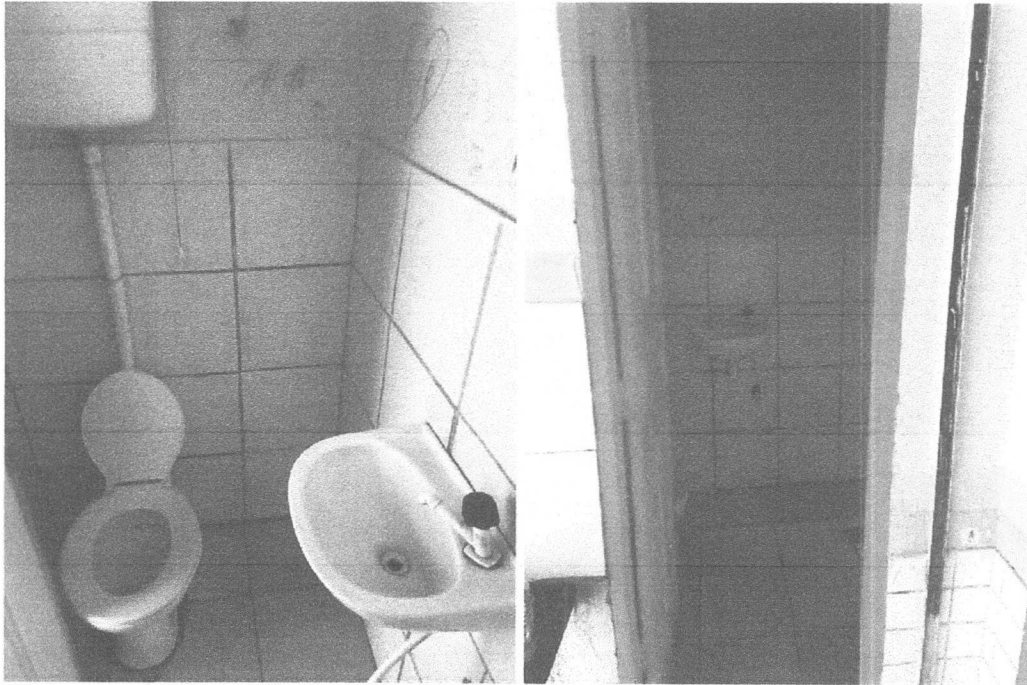
Figura 07: banheiro da U.E Bernarda Portela da Ponte.
