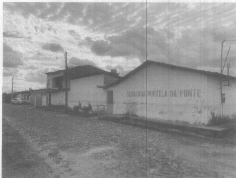
Figura 02: fachada principal da U.E Bernarda Portela da Ponte..
