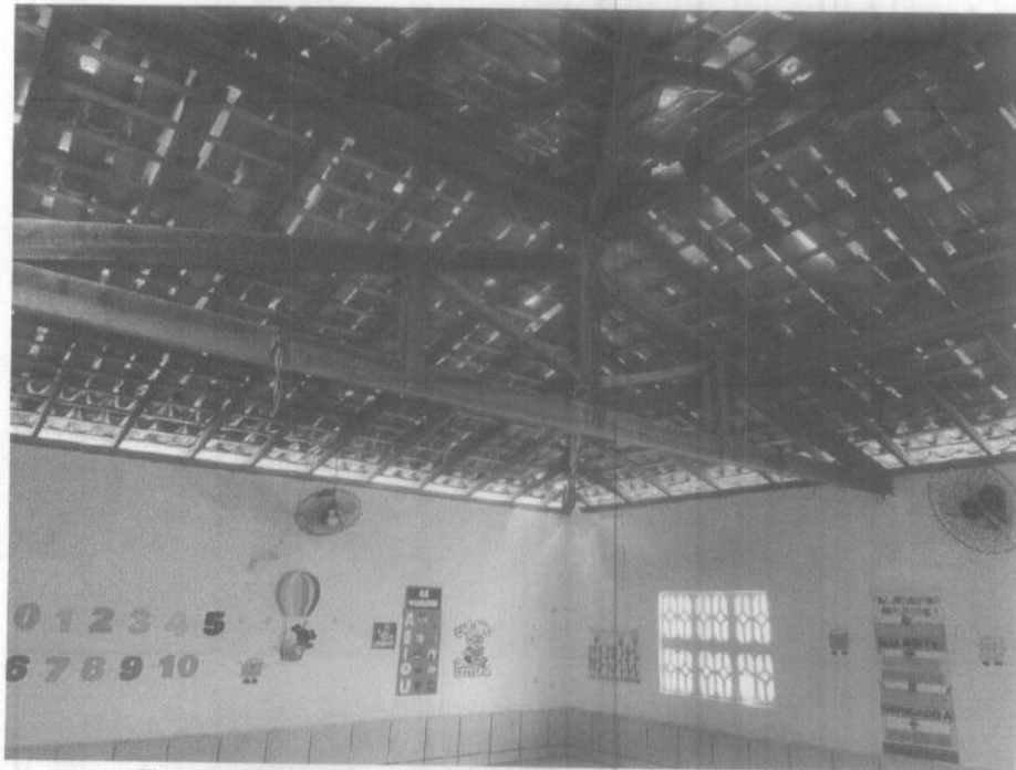
Figura 14: vista da trama de madeira (tesoura de madeira). Fonte: Autora – 2022
