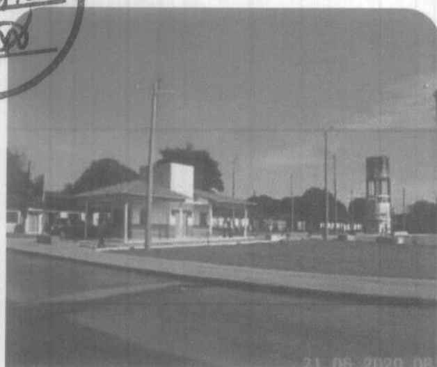
Praça do Bairro Cidade Nova em Rosário/MA
