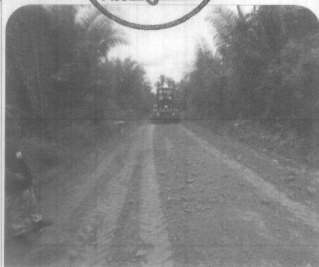
Recuperação de Estrada Vicinal no Município de Rosário/MA
