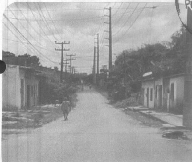
Pavimentação Asfáltica na Sede do Município de Itapecuru Mirim/MA
