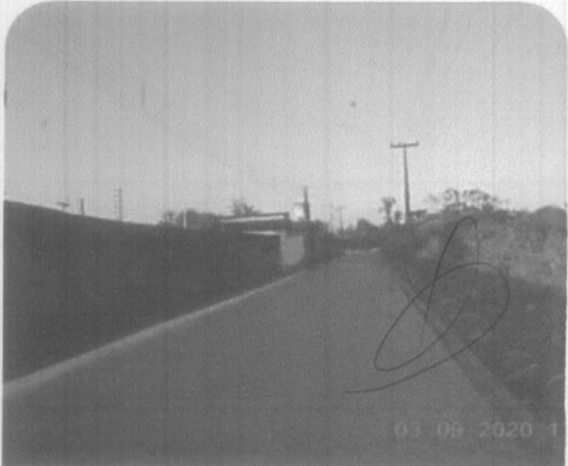
Pavimentação de Bloqret, Bairro Cohab 2 no Município de Rosário/MA
