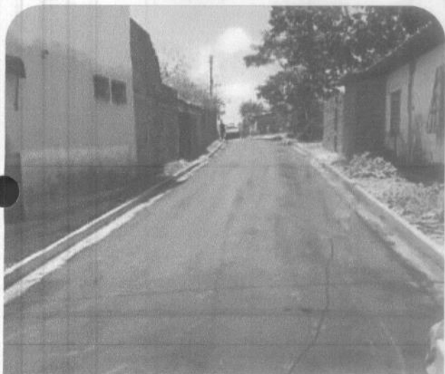
Pavimentação Asfáltica no Município de Rosário/MA
