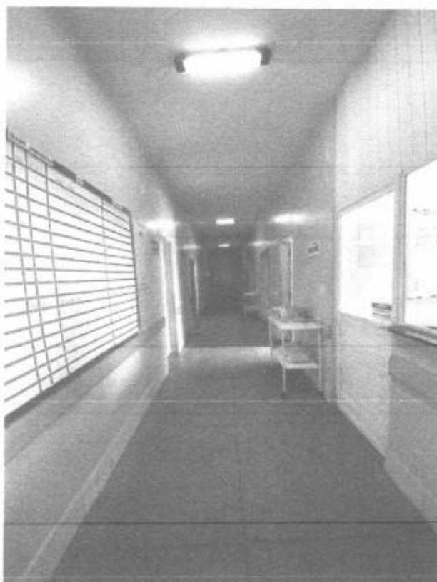
Imagem 3 - Alteração de toda instalação elétrica.
