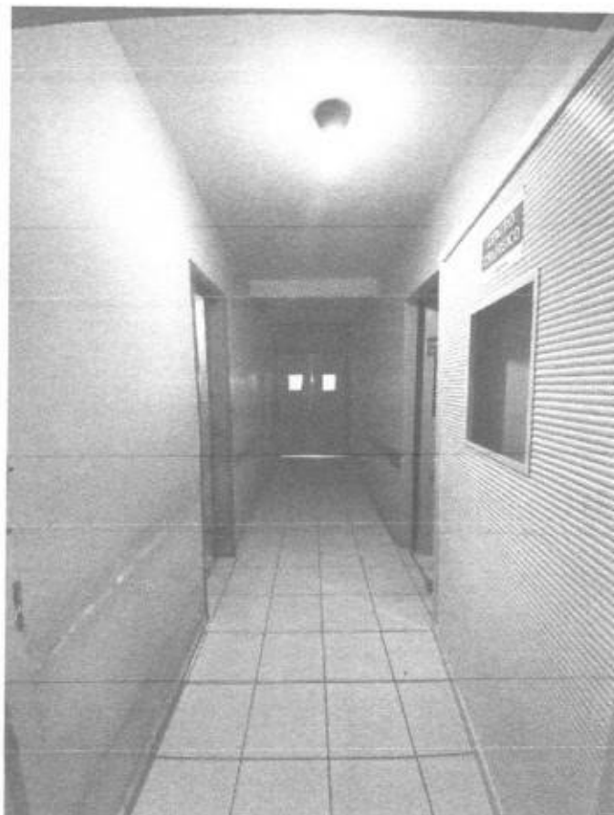
Imagem 5 – Troca de toda instalação elétrica.
