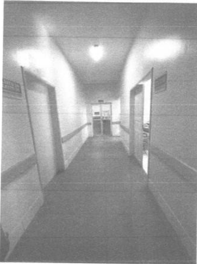
Imagem 4 – Necessário trocar o sistema de instalação elétrica .
