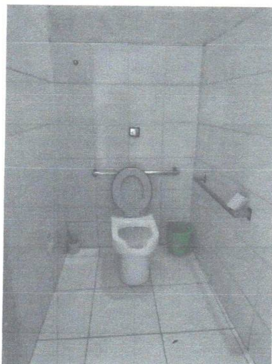
Imagem 24– Banheiro pcd feminino
