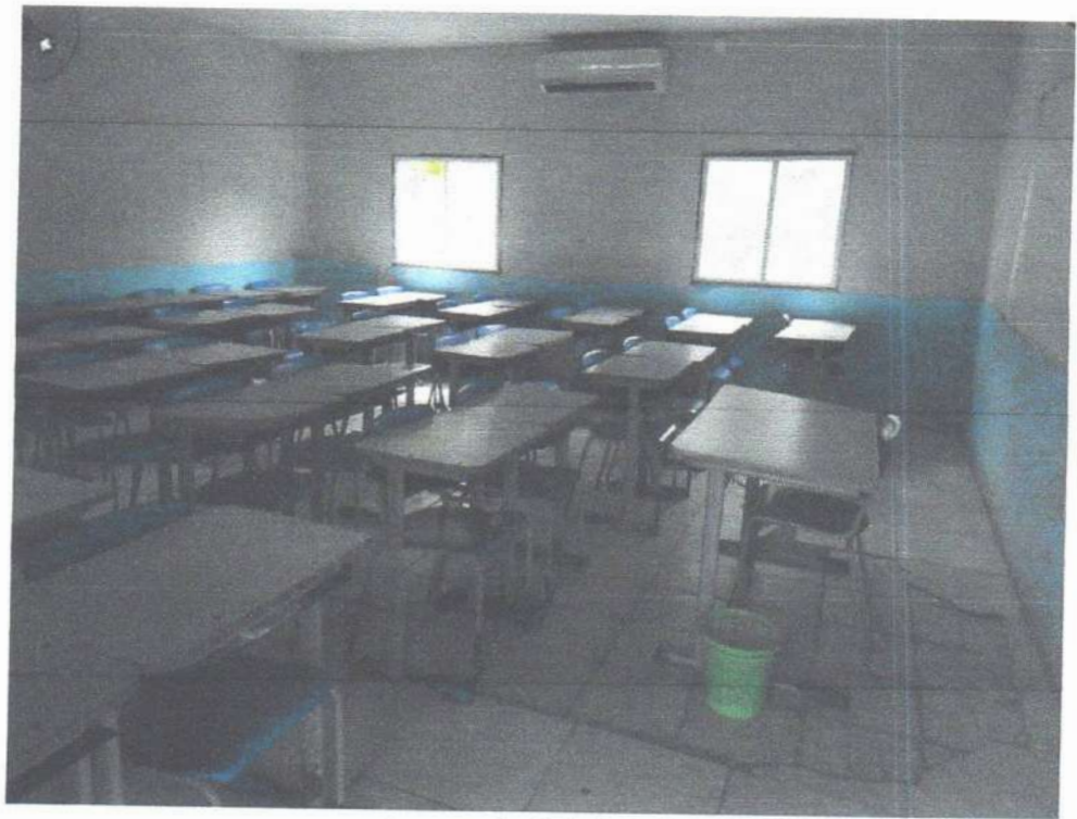
Imagem 9 – Sala de Aula
