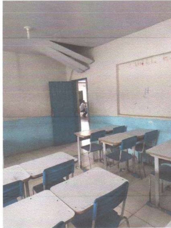
Imagem 13 – Forro em sala de aula
