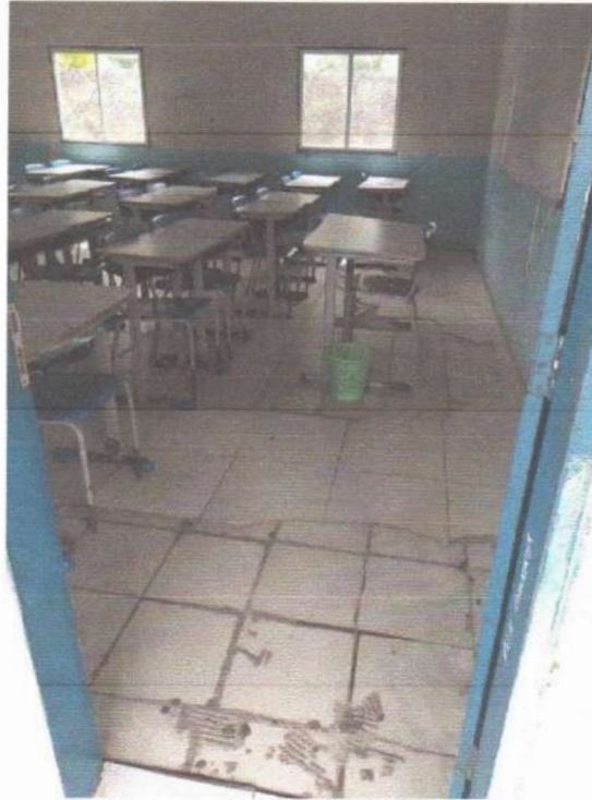
Imagem 5 – Piso de sala de aula
