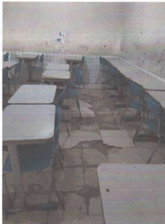
Imagem 6 – Piso de sala de aula
