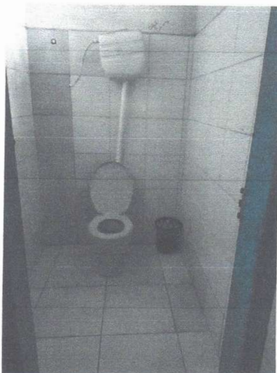
Imagem 25- Banheiro feminino sem porta
