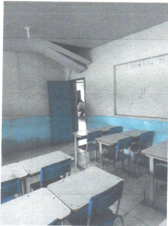
Imagem 13 – Forro em sala de aula
