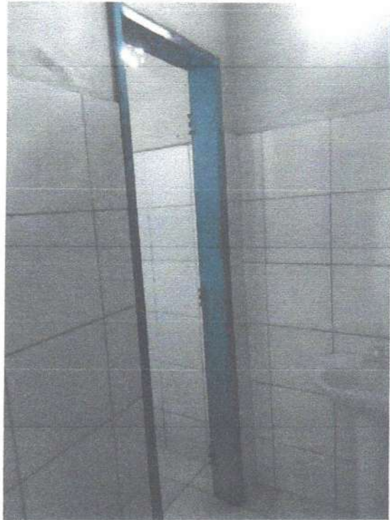
Imagem 27- Banheiro feminino sem porta
