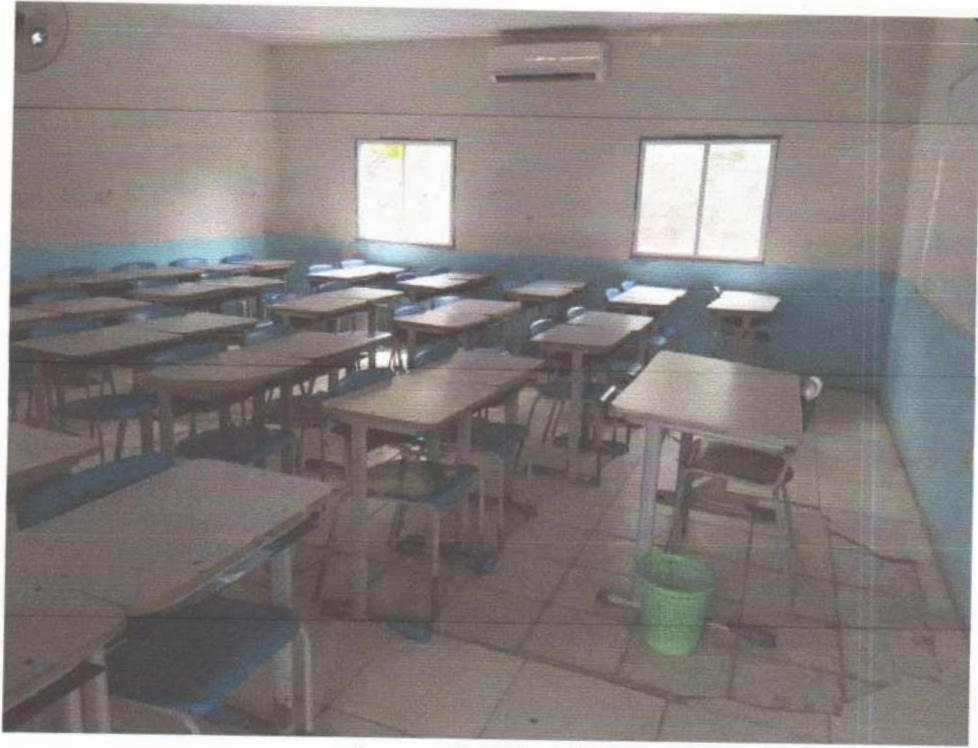
Imagem 9 – Sala de Aula
