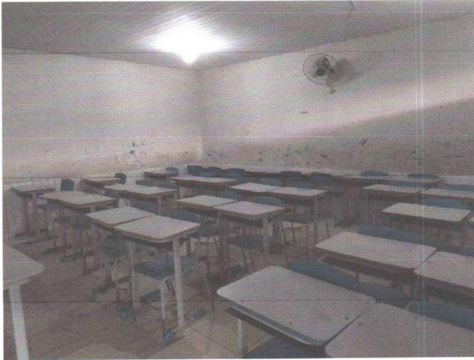
Imagem 7 – Sala de aula
