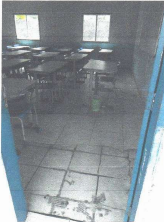
Imagem 5 – Piso de sala de aula
