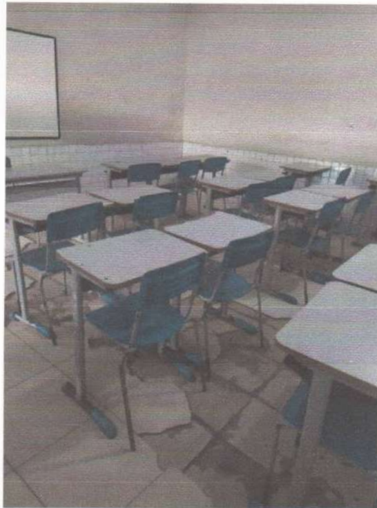
Imagem 4 – Piso de sala de aula
