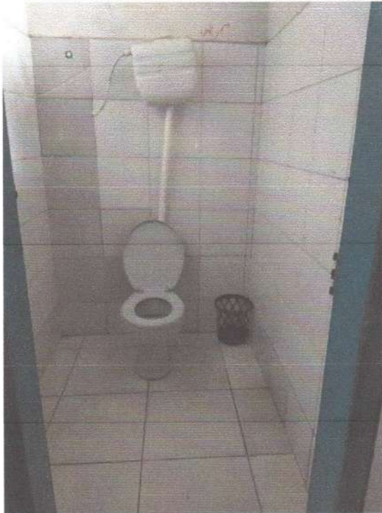
Imagem 25- Banheiro feminino sem porta
