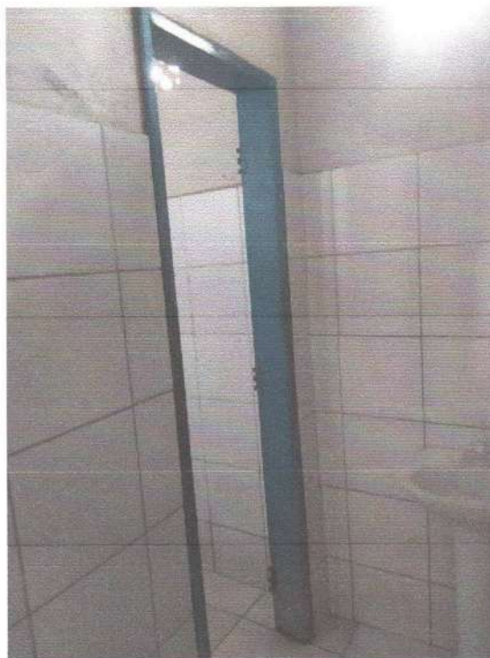
Imagem 27– Banheiro feminino sem porta
