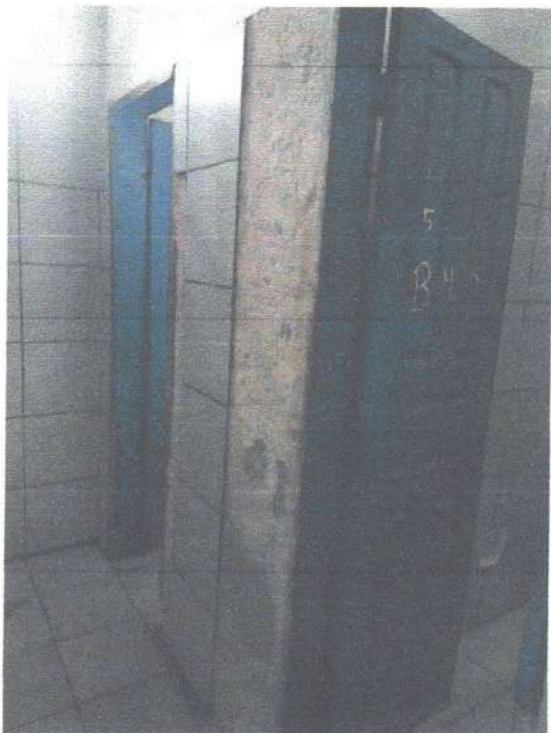
Imagem 21- Banheiro com deslocamento
