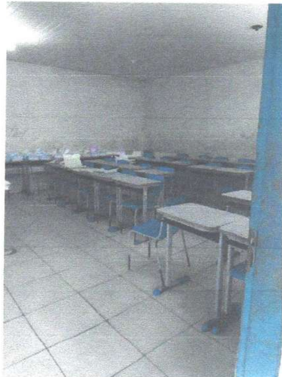
Imagem 12– Sala de aula
