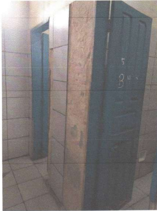
Imagem 21- Banheiro com deslocamento
