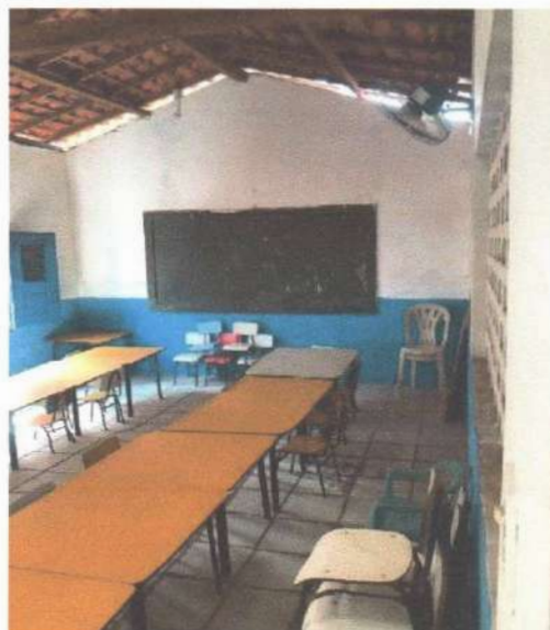
Imagem 2 – Sala de Aula
