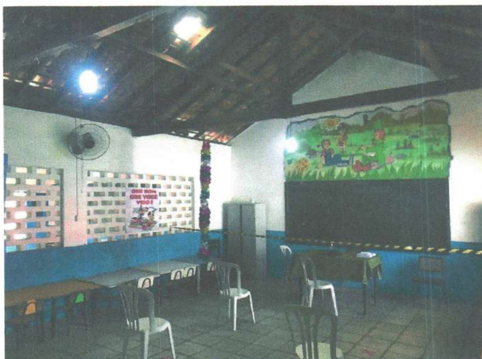
Imagem 4 – Sala de Aula
