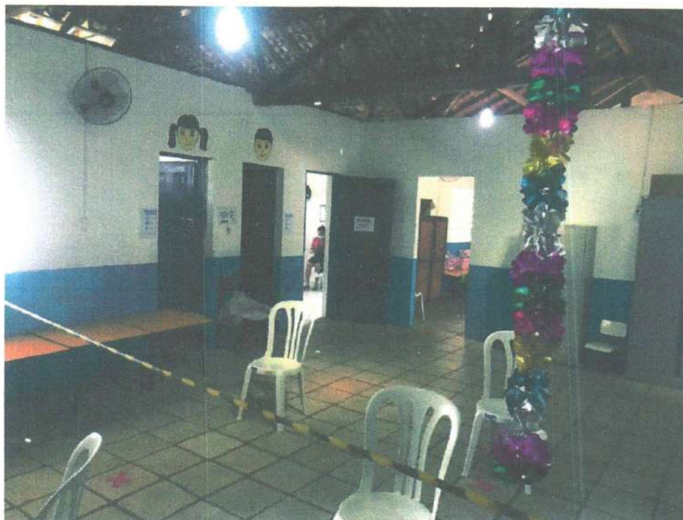
Imagem 3 – Sala de Aula
