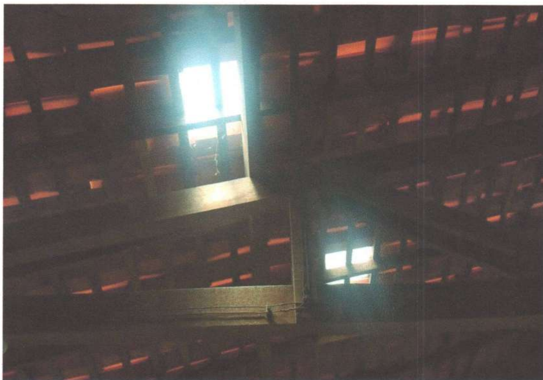
imagem 27 - Manutenção de telhado
