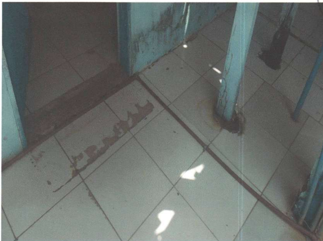
imagem 35 – Troca de piso desgastado, e soleira.
