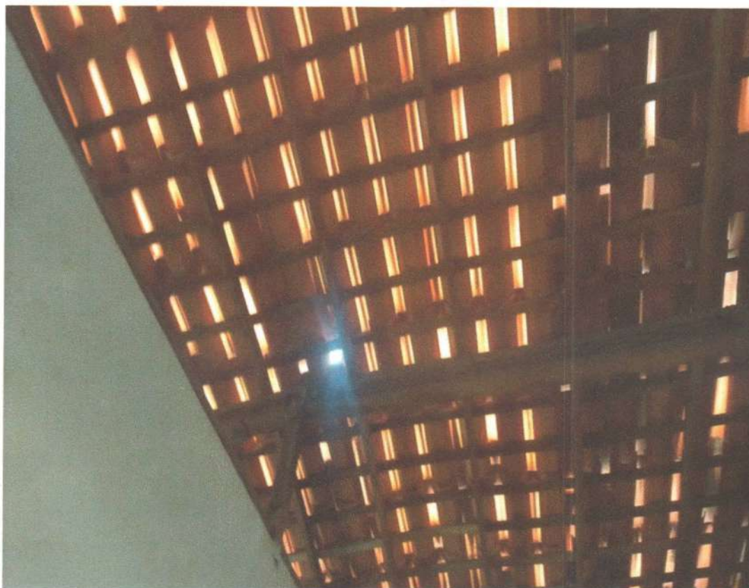
imagem 31 - Manutenção de telhado
