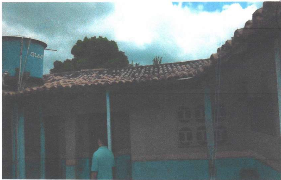
imagem 19 – Troca de estrutura da caixa d'água
