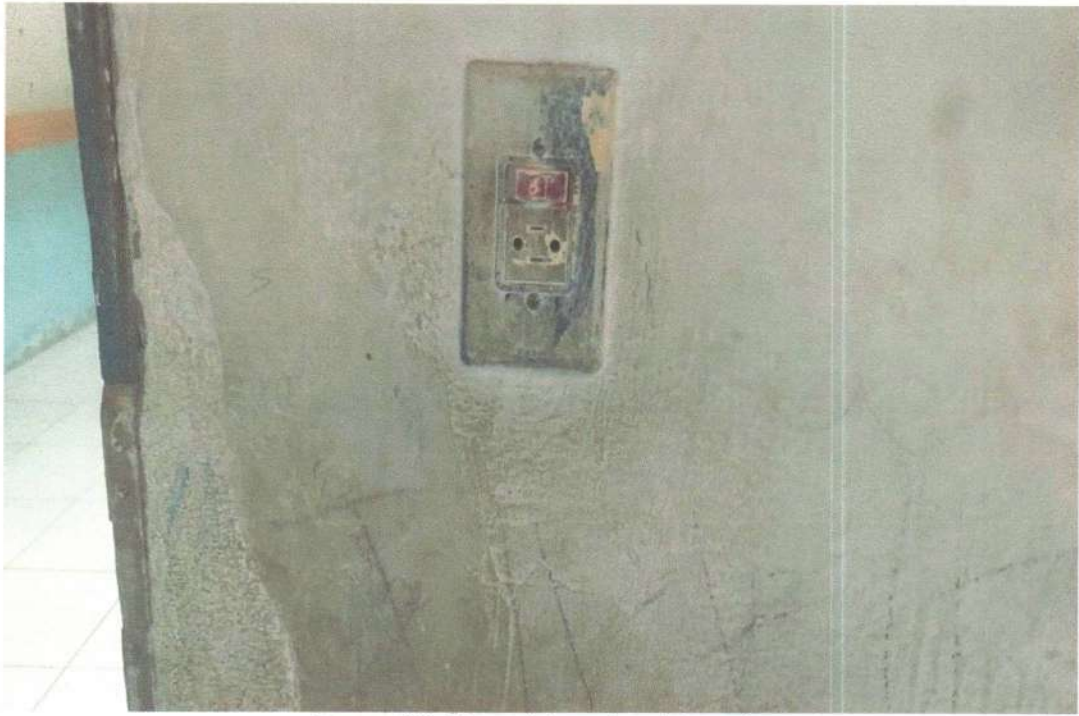
imagem 25 - Troca de tomada, e interruptor
