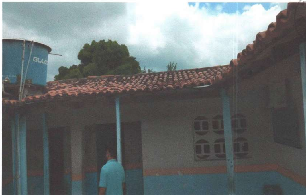
imagem 19 – Troca de estrutura da caixa d'água
