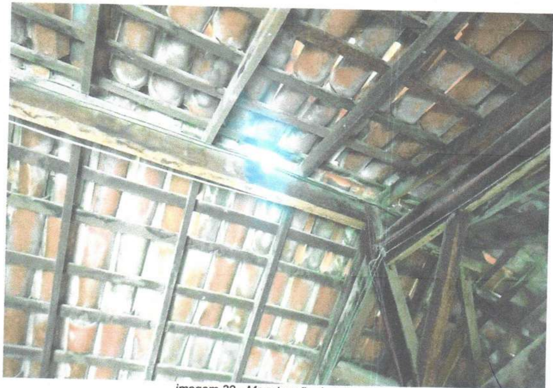
imagem 32 - Manutenção de telhado
