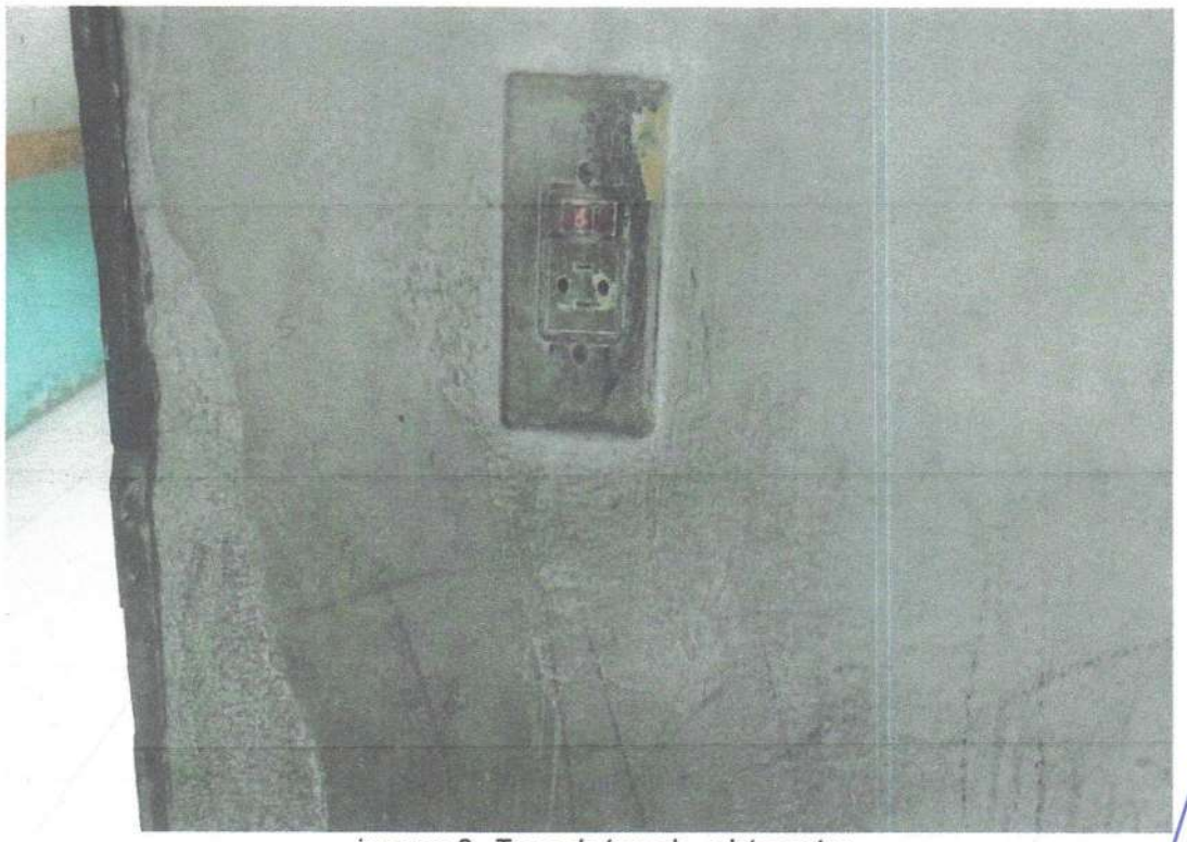
imagem 8 - Troca de tomada, e interruptor
