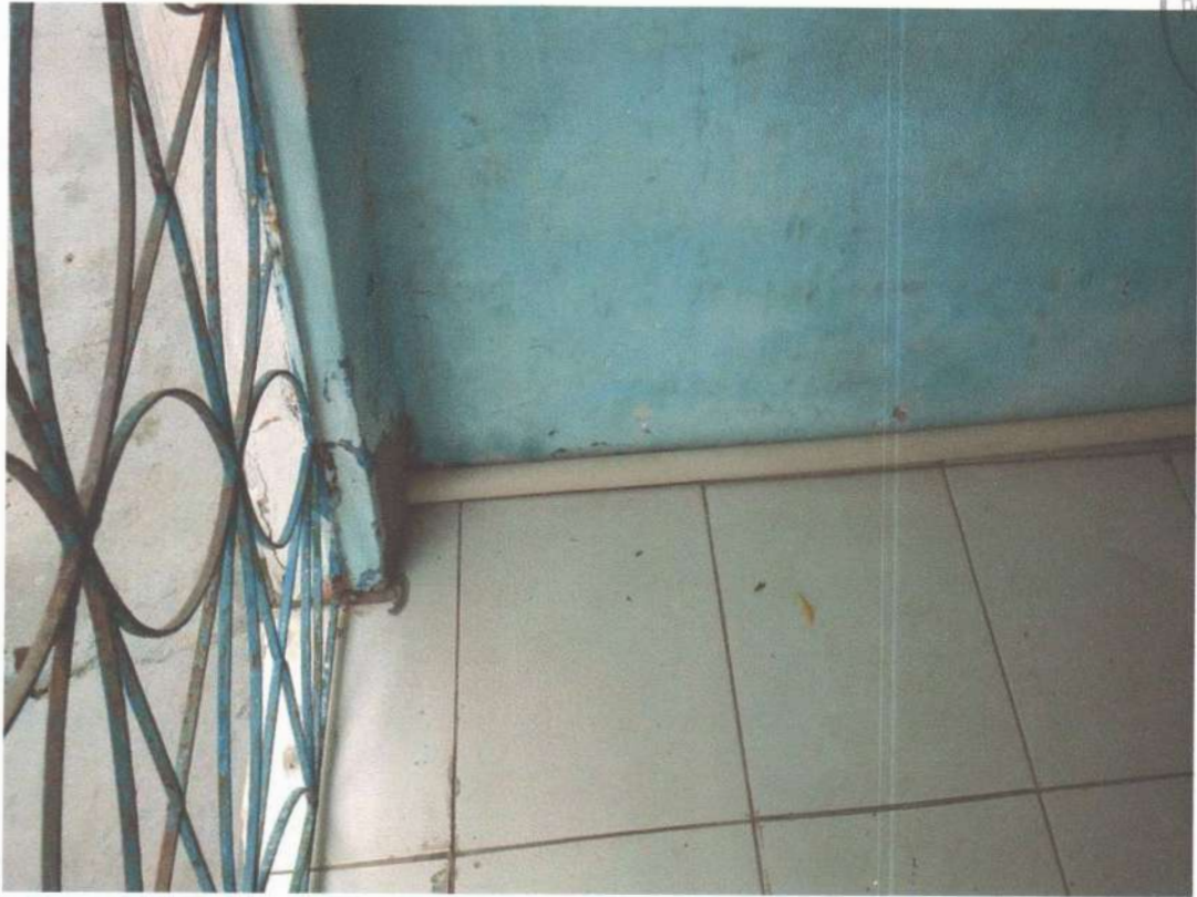
imagem 33 - Recuperação de esquadria de ferro
