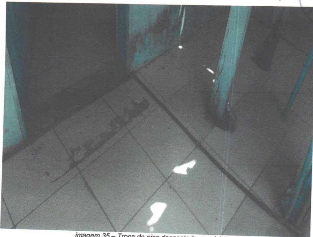
imagem 35 - Troca de piso desgastado, e soleira.
