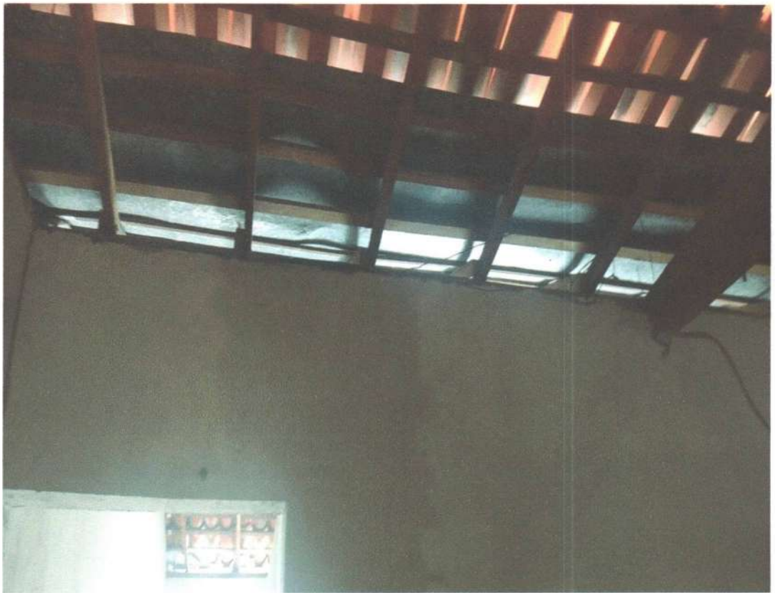
imagem 14 - Troca de calha
