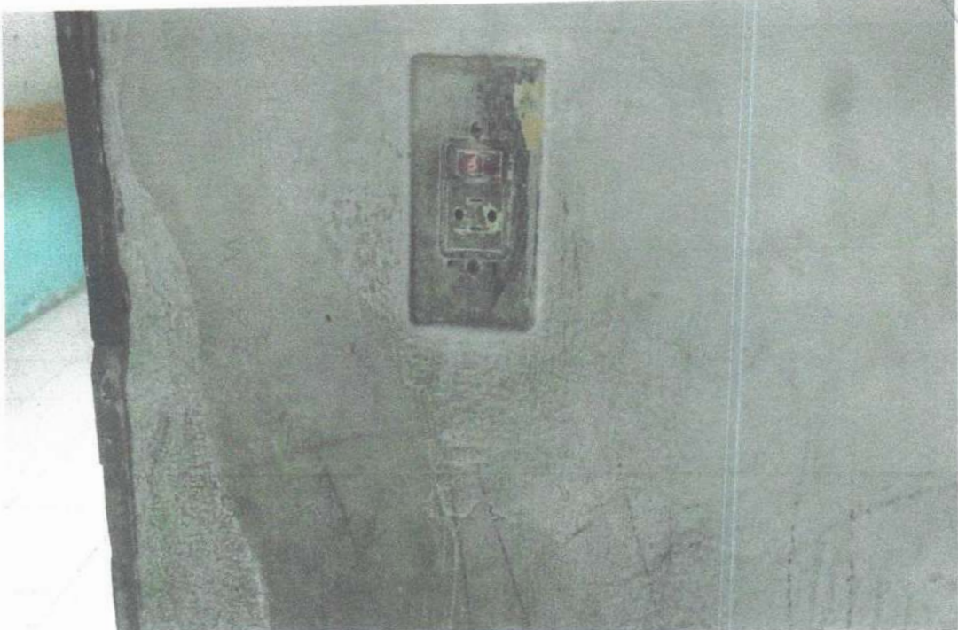
imagem 25 - Troca de tomada, e interruptor
