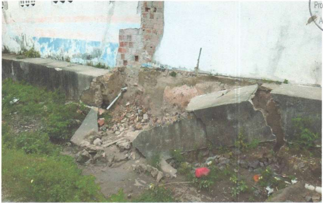
imagem 39 - Construção de fossa e sumidouro
