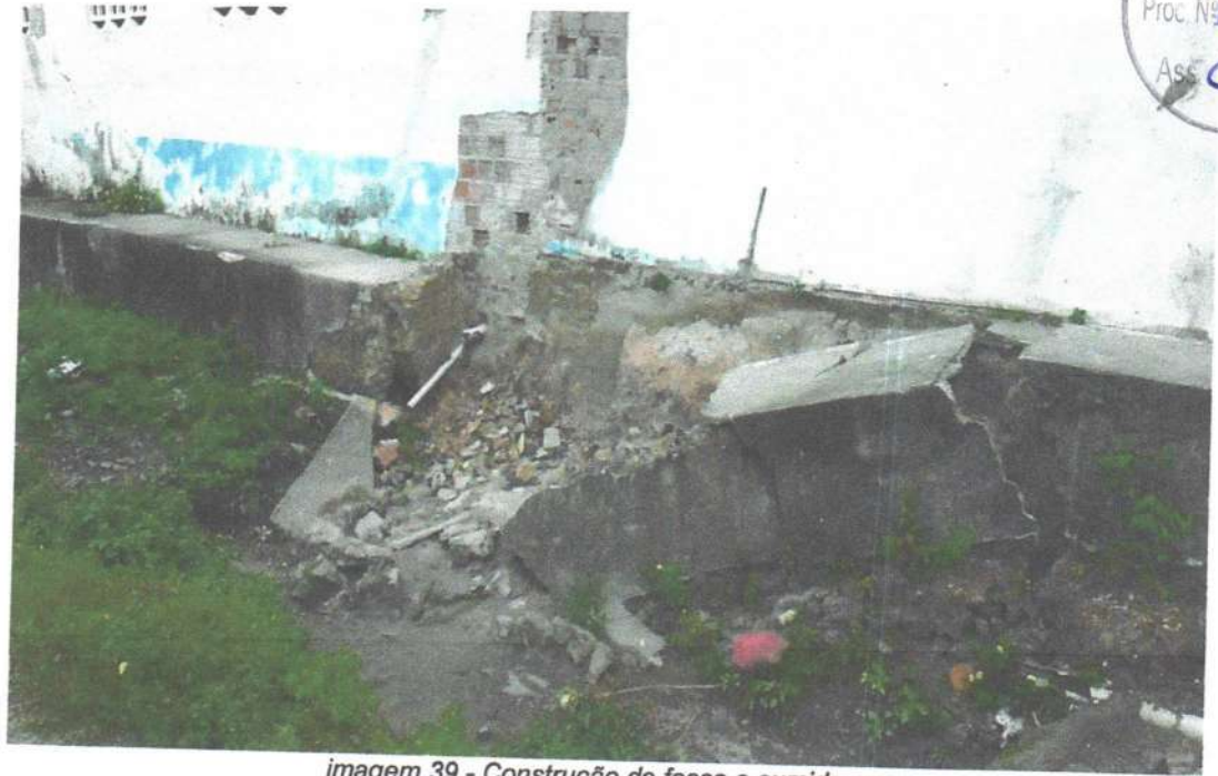
imagem 39 - Construção de fossa e sumidouro
