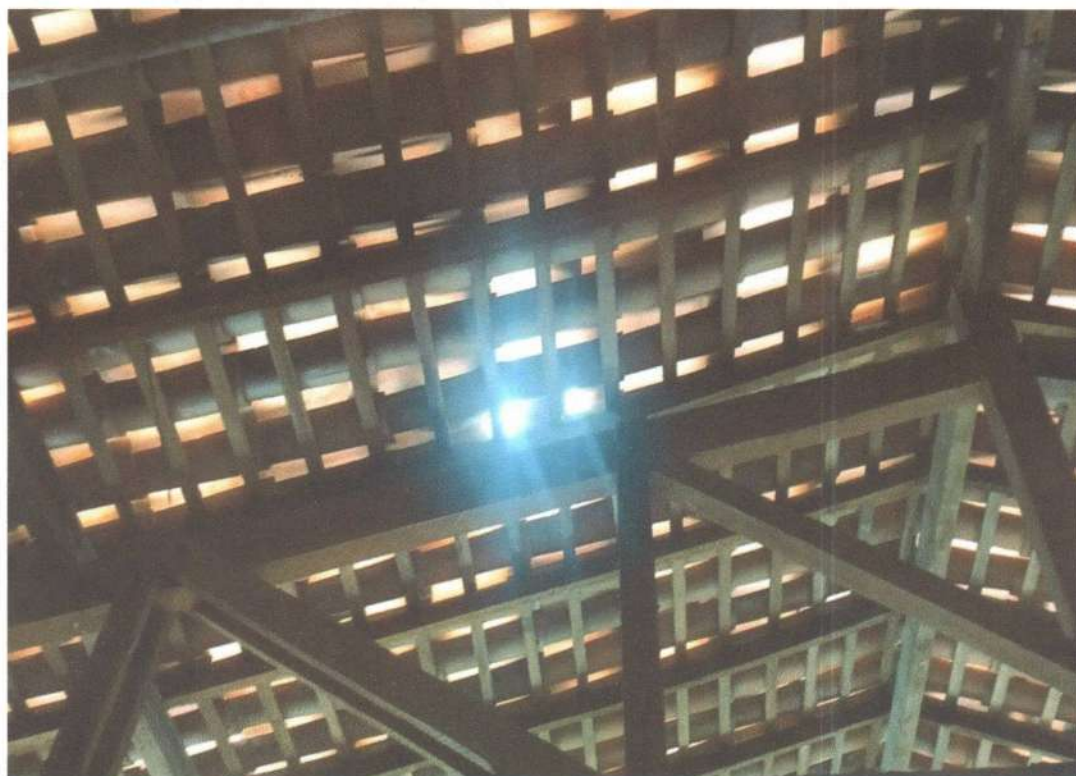
imagem 28 - Manutenção de telhado
