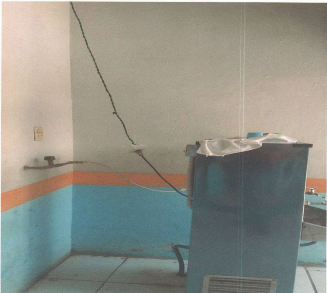
imagem 34 - Manutenção das instalações do bebedouro
