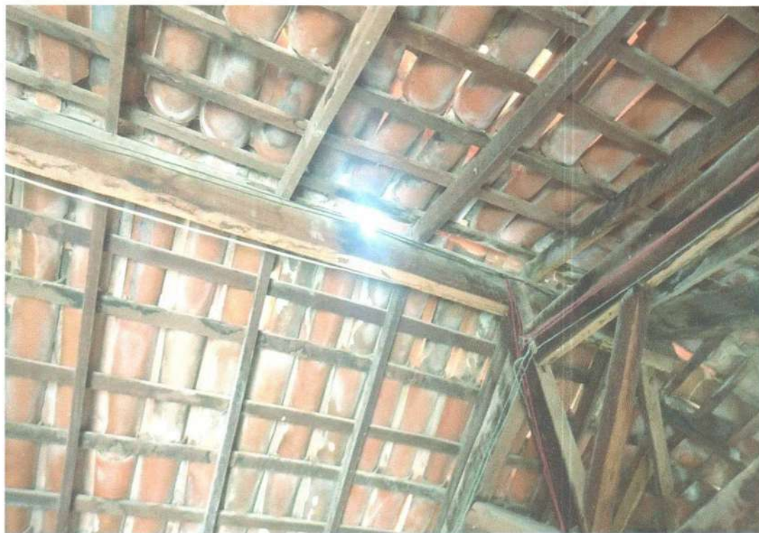
imagem 32 - Manutenção de telhado
