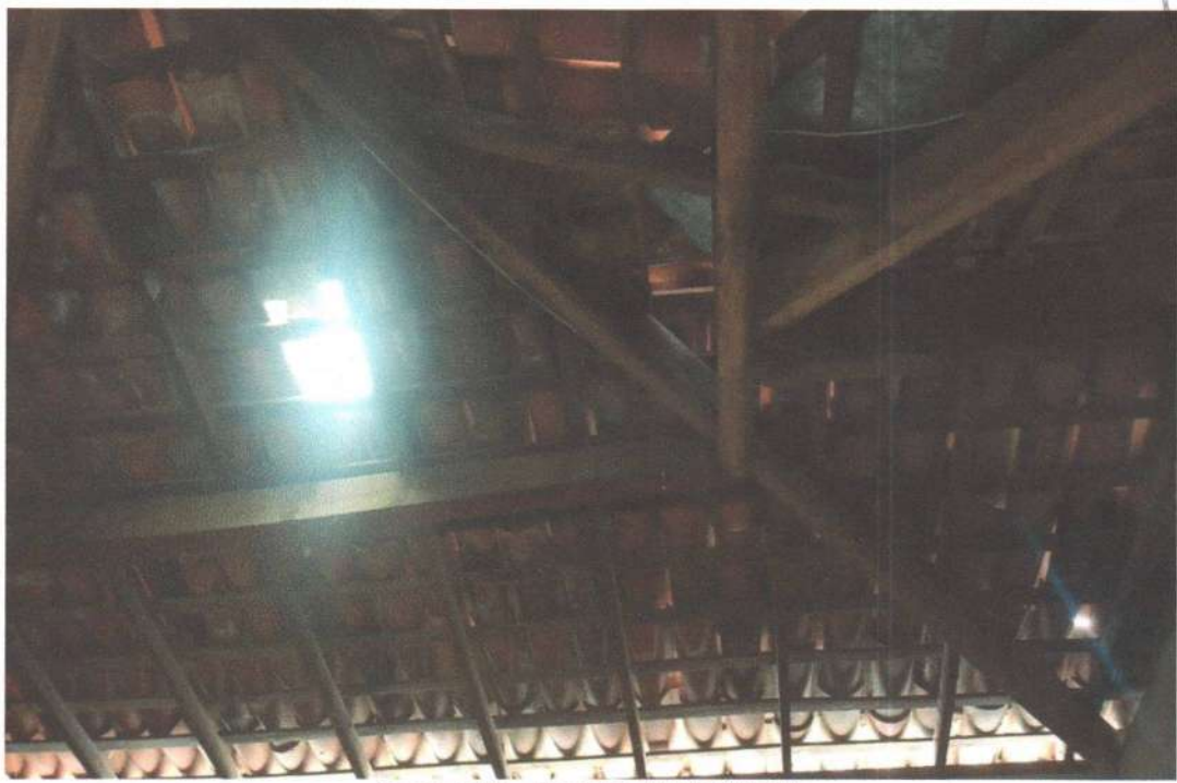
imagem 29 - Manutenção de telhado
