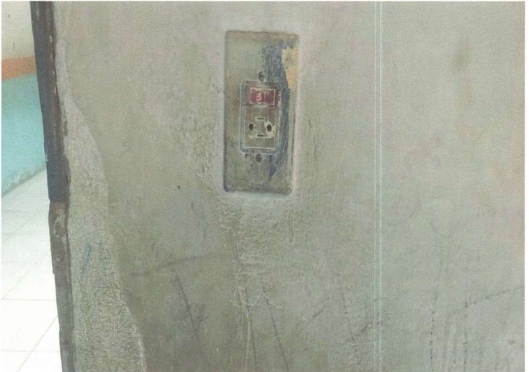
imagem 8 - Troca de tomada, e interruptor
