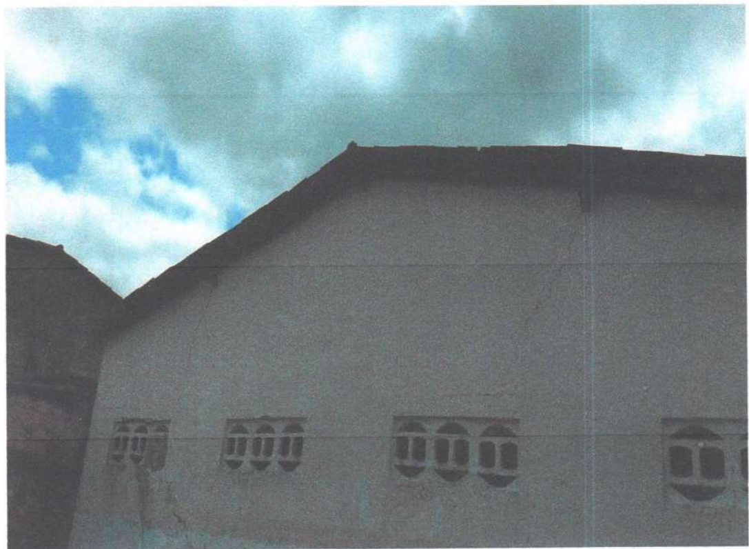
imagem 4 - Parede rachada
