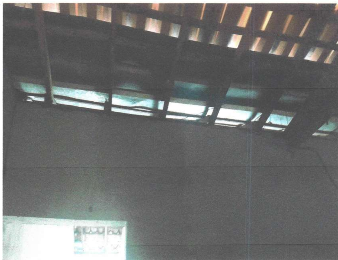
imagem 14 - Troca de calha
