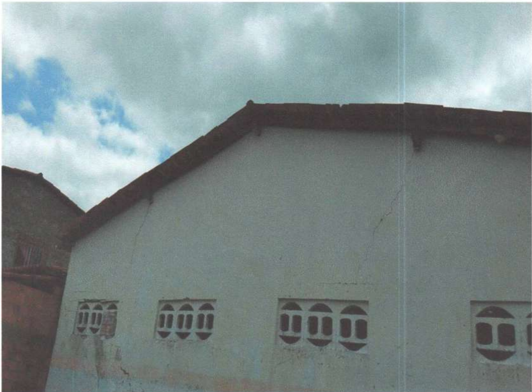
imagem 4 - Parede rachada
