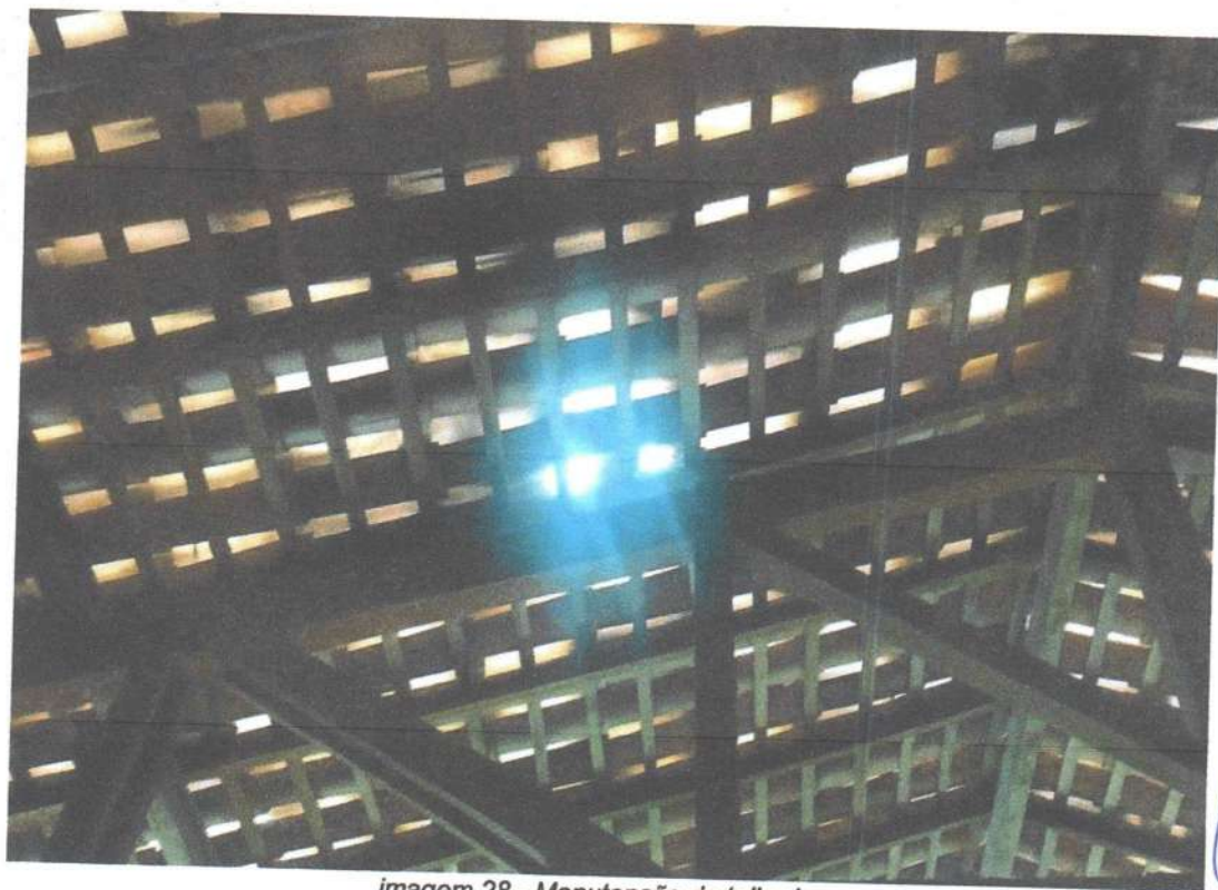
imagem 28 - Manutenção de telhado
