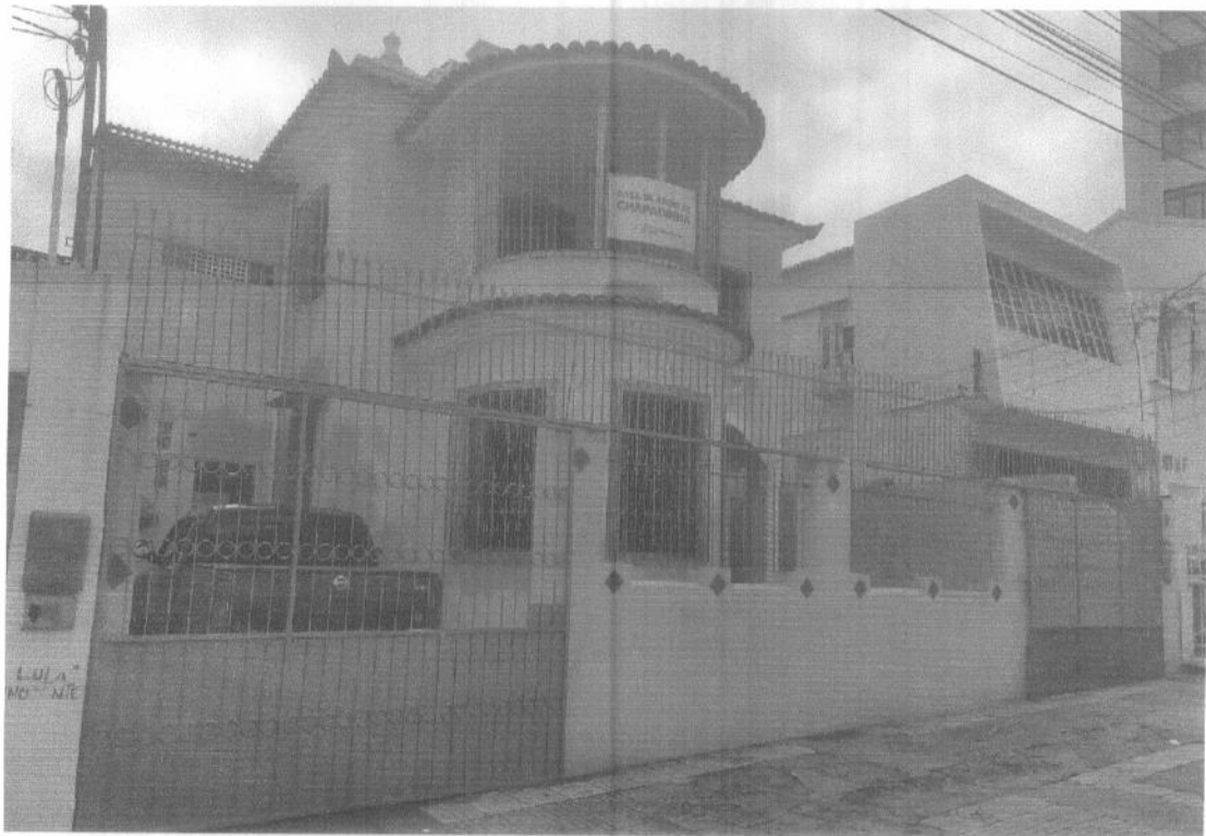
CASA DE APOIO, RUA DO EGITO Nº 221, BAIRRO: CENTRO, SÃO LUÍS – MA.
