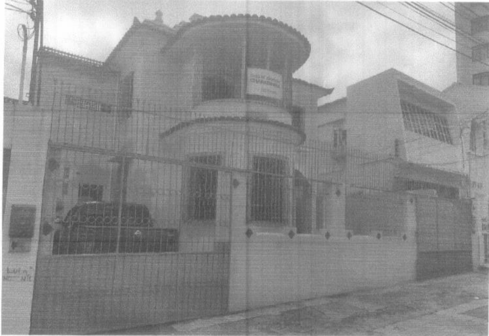
Fachada Fonte: Acervo Técnico (2021)
