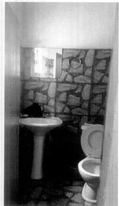
Banheiro 1 Fonte: Acervo Técnico (2021)
