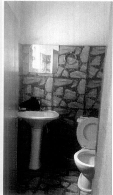
Banheiro 1 Fonte: Acervo Técnico (2021)
