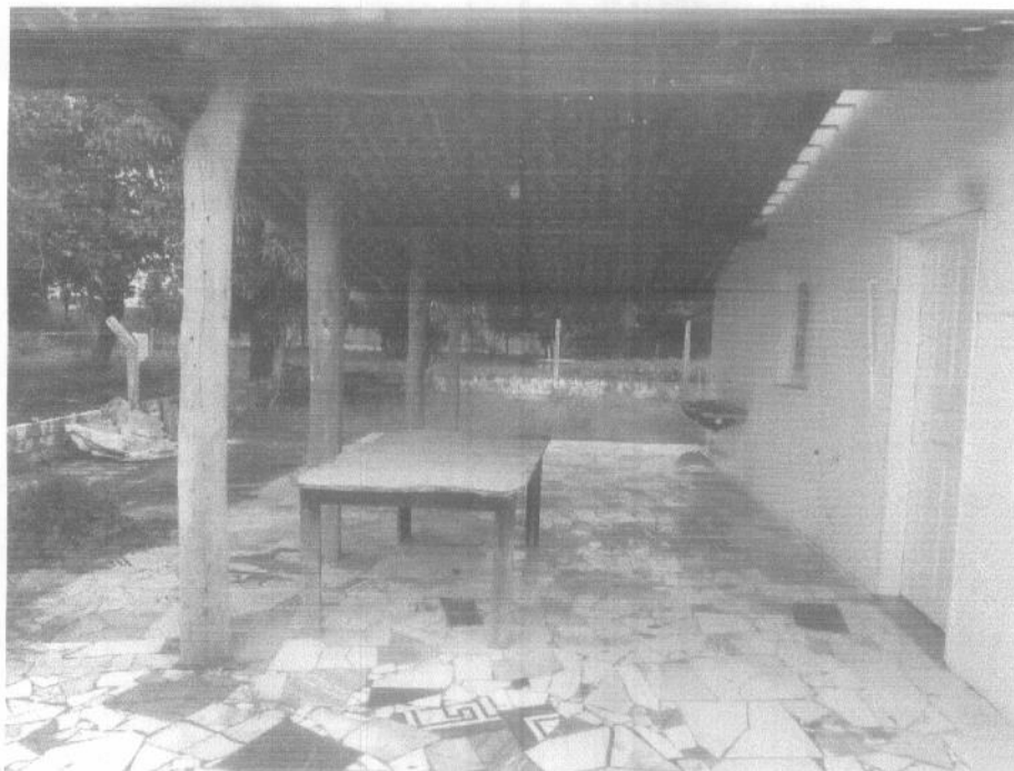
Área dos Fundos/ Lavanderia
