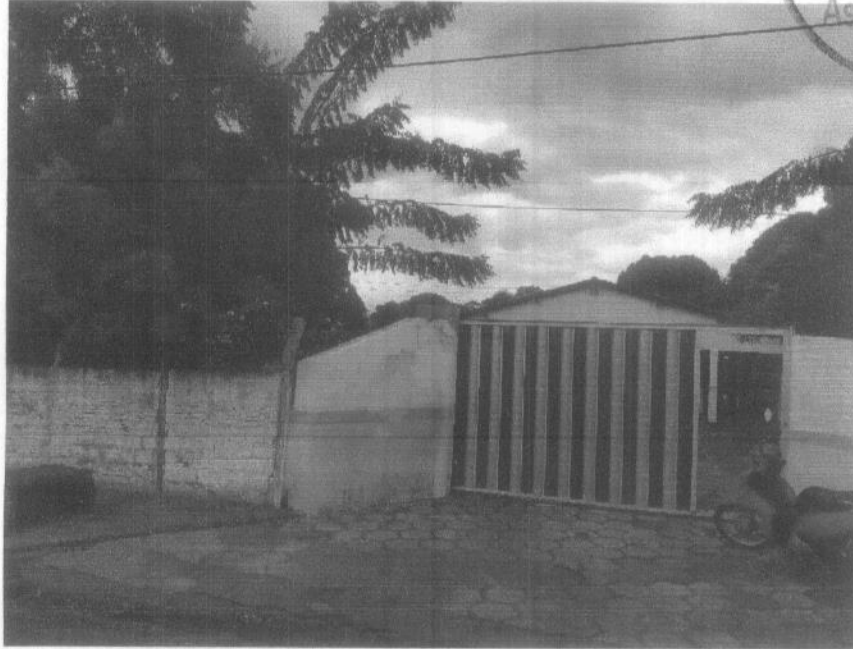
Fachada Fonte: Acervo Técnico (2021)
