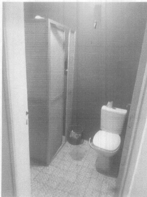
Banheiro Fonte: Acervo Técnico (2021)
