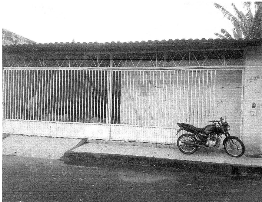
Fachada Fonte: Acervo Técnico (2021)
