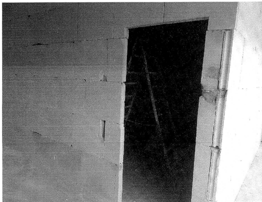
Anexo da entrada em construção Fonte: Acervo Técnico (2021)
