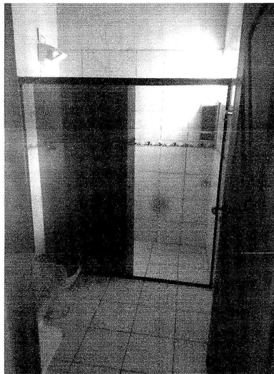
Banheiro 1 Fonte: Acervo Técnico (2021)
