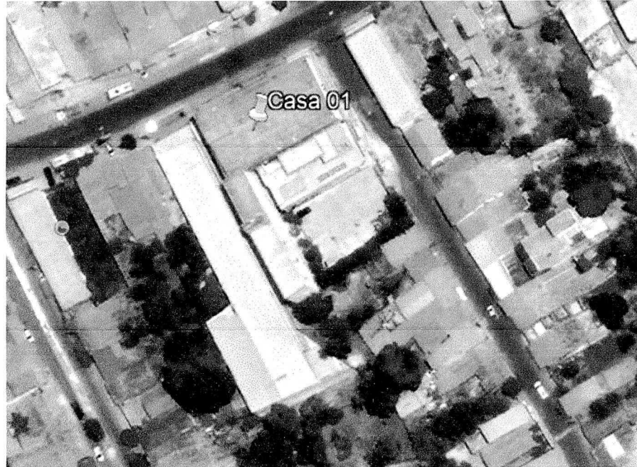
Amostra 2 – Imóvel situada na Av. Ataliba Vieira de Almeida Fonte: Google Earth (2021)
