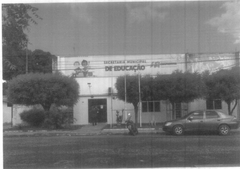
Fachada Fonte: Acervo Técnico (2021)
