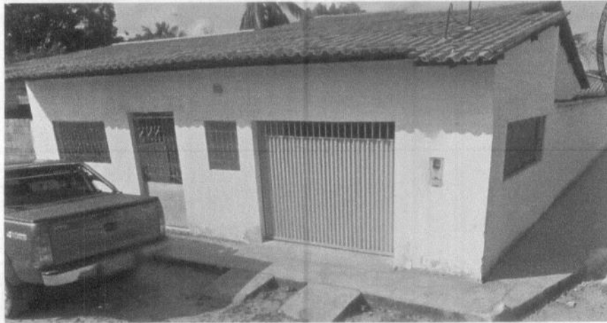
Fachada Fonte: Acervo Técnico (2021)
