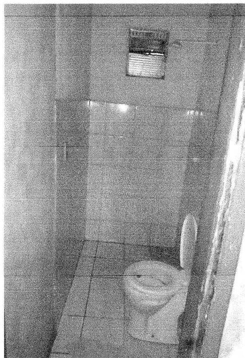
Banheiro 1 Fonte: Acervo Técnico (2021)
