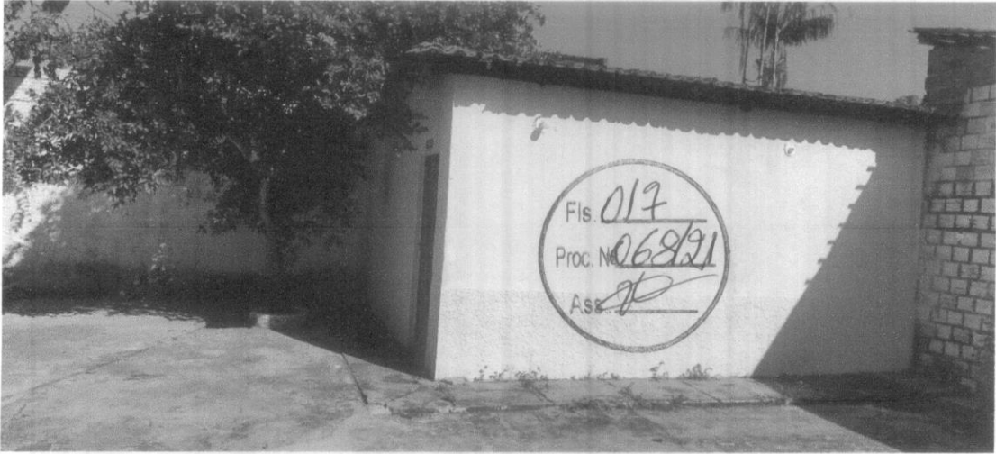
Depósito Fonte: Acervo Técnico (2021)
