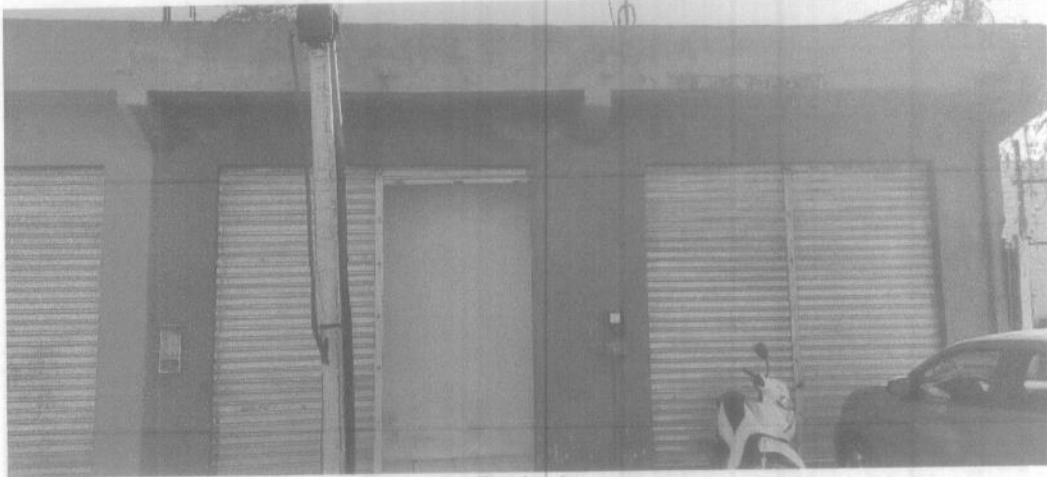
Fachada Fonte: Acervo Técnico (2021)
