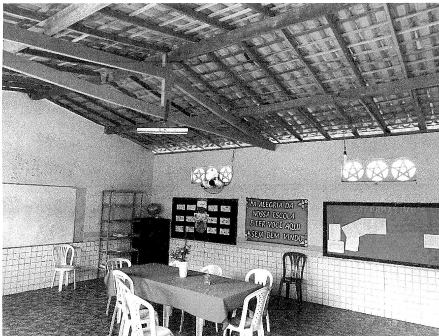
Imagem 4 – Secretária com pintura danificada
