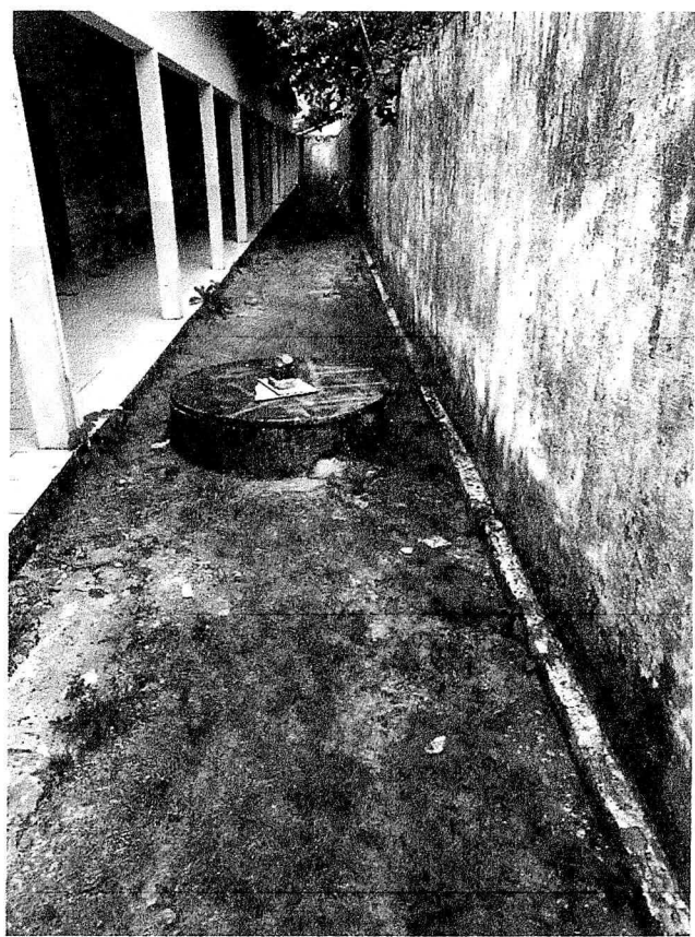
Imagem 38 – corredor acesso as salas
