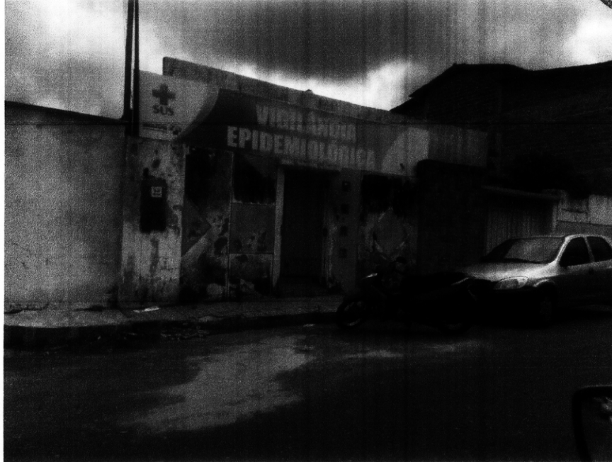
Fachada Fonte: Acervo Técnico (2023)
