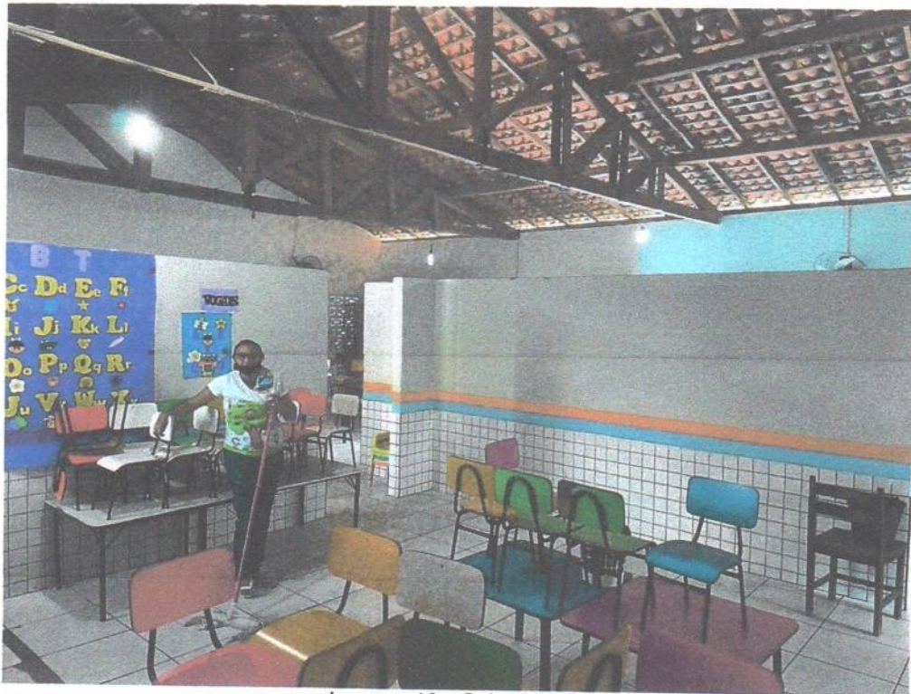
Imagem 16 – Sala de Aula
