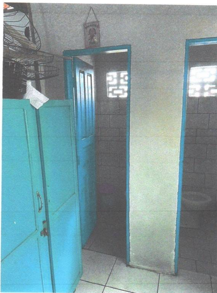
Imagem 21 – Banheiros da Escola
