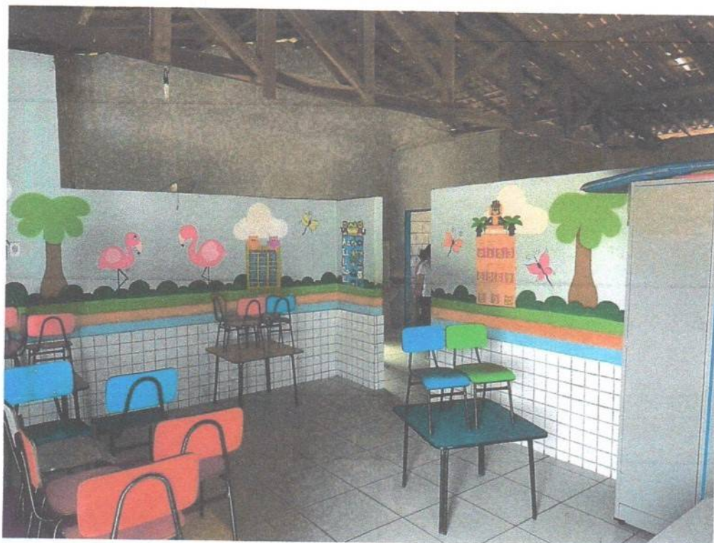
Imagem 20 – Sala de Aula
