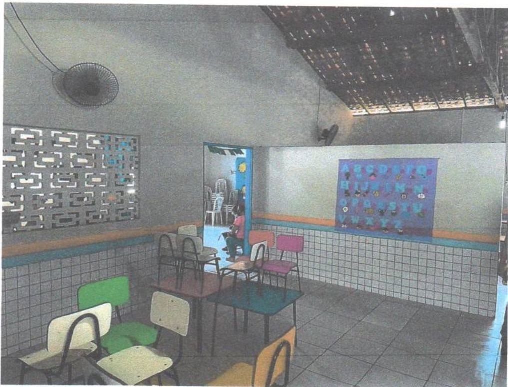
Imagem 13 – Sala de Aula
