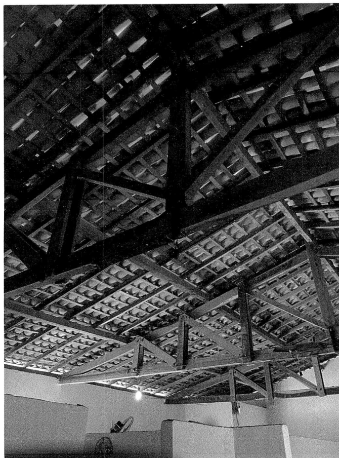
Imagem 27 – Manutenção na Cobertura da Escola
