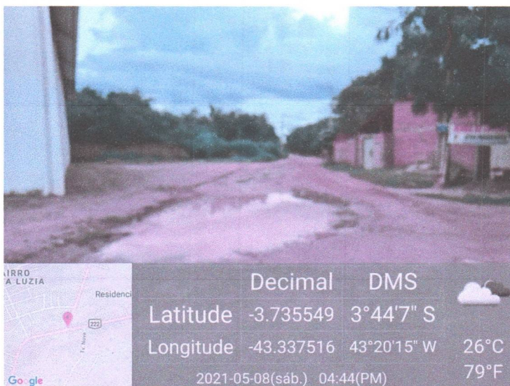
FOTO 01- Início de trecho (Rodovia MA-230)
