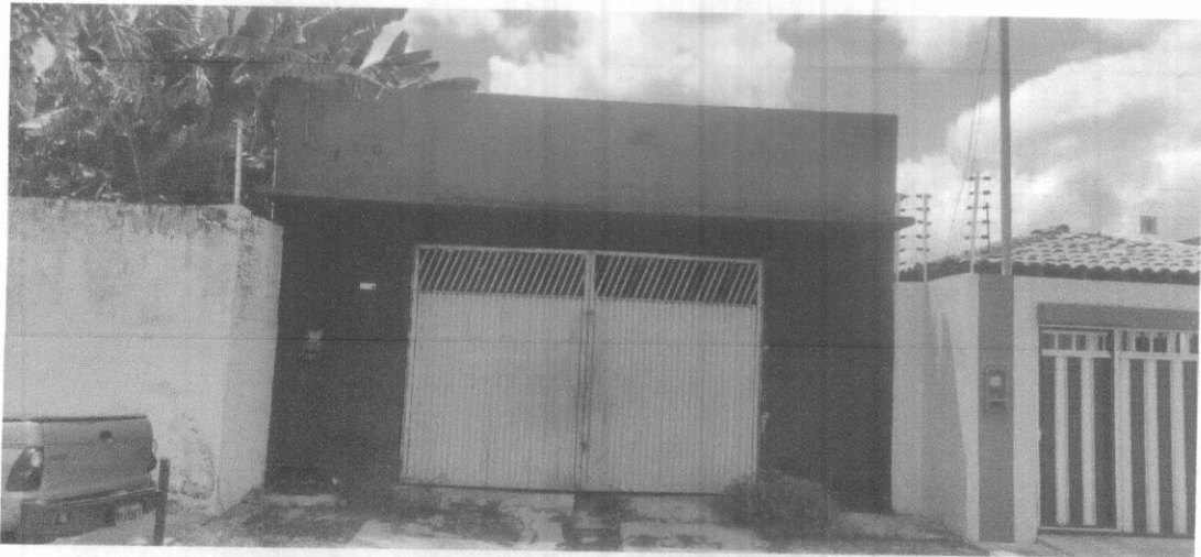
ALMOXARIFADO DE CARTEIRAS ESCOLARES, RUA DO COMÉRCIO, Nº 1208, BAIRRO: CENTRO
