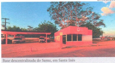
Base descentralizada do Samu, em Santa Inês
