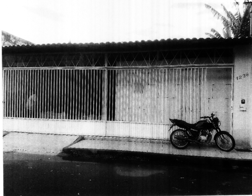
Fachada Fonte: Acervo Técnico
