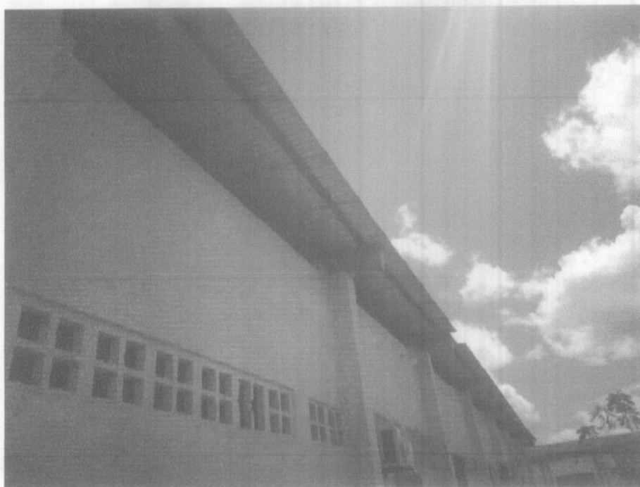
Imagem 10 – vista lateral da cobertura metálica do ginásio.
