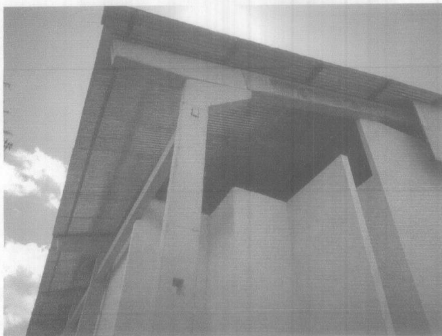
Imagem 16 – estrutura pré-moldada de concreto, cobertura em chapa metálica.
