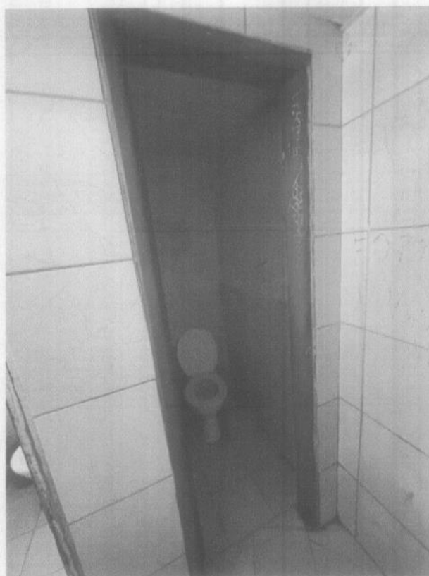
imagem 11 – Revestimento danificado
