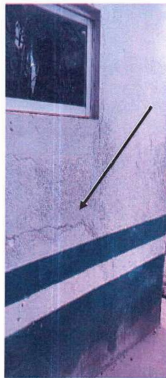
IMAGEM CASO 03 – Identificação de fissura em 45° oriundas do solo, ocasionando descolamento da alvenaria em área externa da escola.
