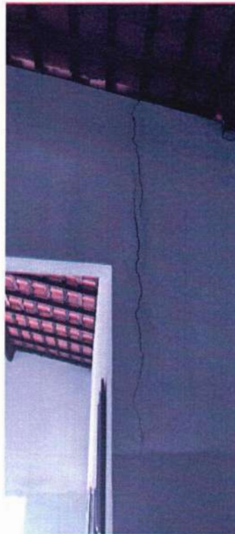
IMAGEM CASO 02 – Identificação de fissura vertical na circulação da edificação
