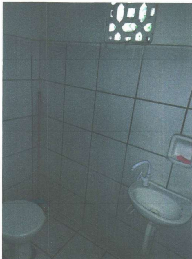
Imagem 29 – Banheiro da escola
