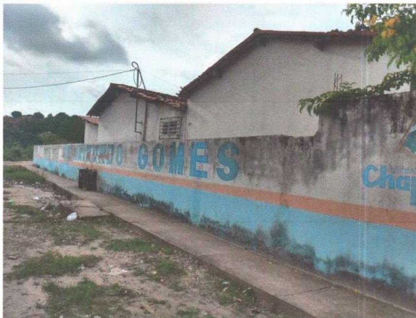
*Imagem 1 – Pintura muro externo danificada*
