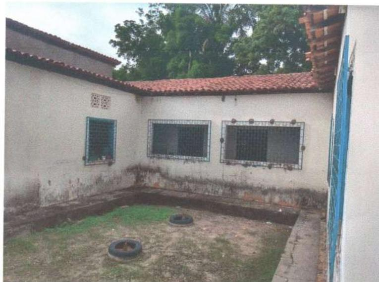
Imagem 14 – Pintura e telhado danificados
