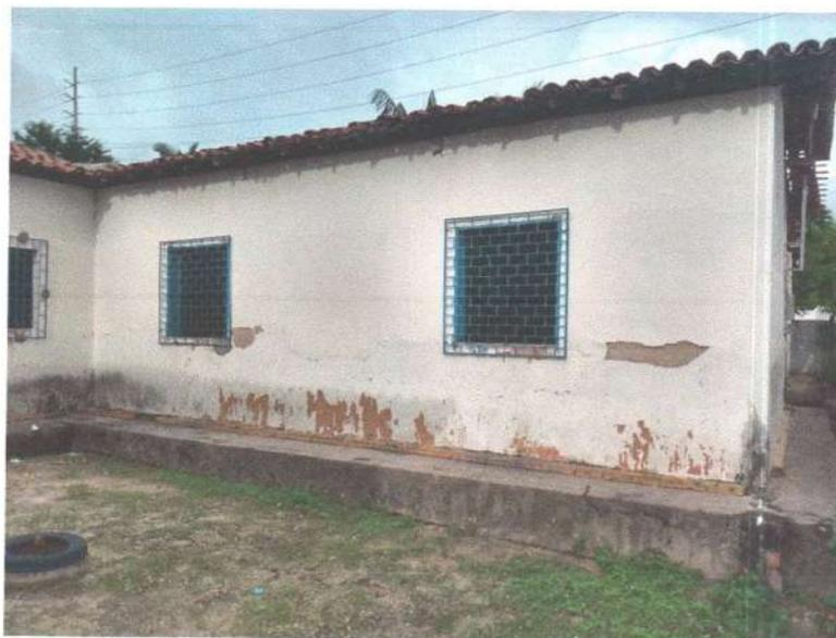
Imagem 13 – Pintura e telhado danificados
