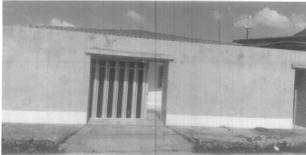
Fachada Fonte: Acervo Técnico (2021)
