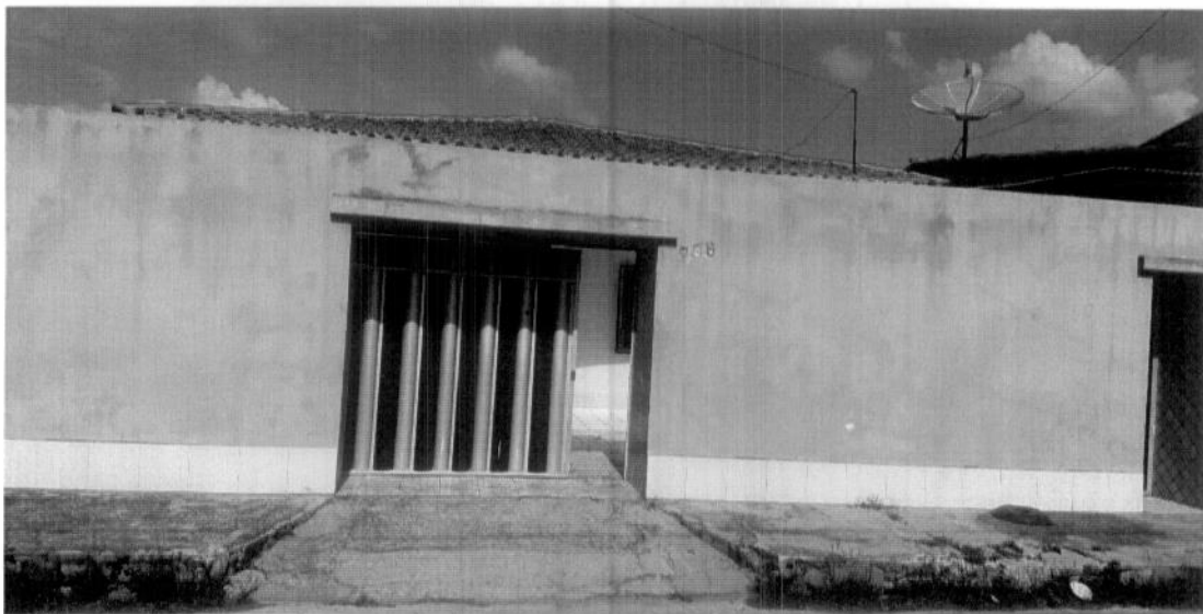
CASA DE PASSAGEM, TRAV. MUCAMBINHO Nº 288, BAIRRO: CORRENTE
