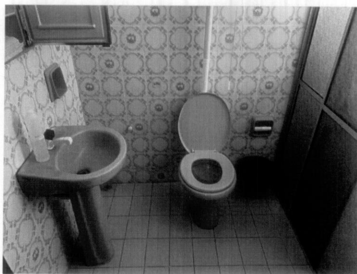
Banheiro 1 Fonte: Acervo Técnico (2021)
