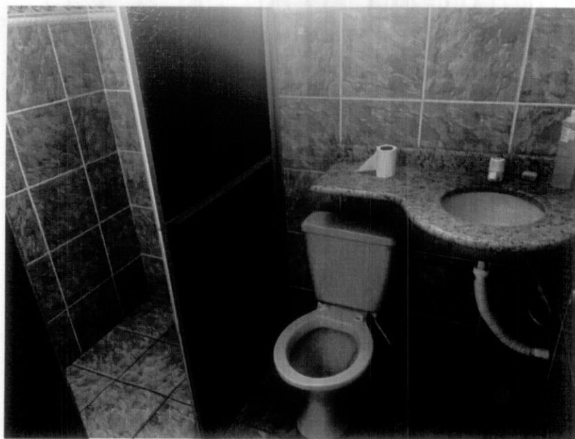
Banheiro 2 Fonte: Acervo Técnico
