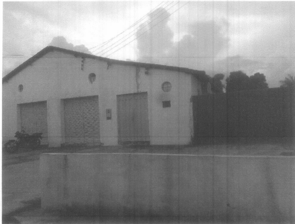
Fachada Fonte: Acervo Técnico (2021)
