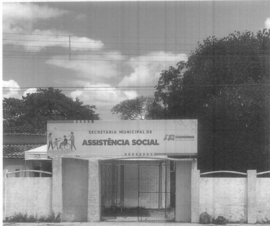
Fachada Fonte: Acervo Técnico (2021)
