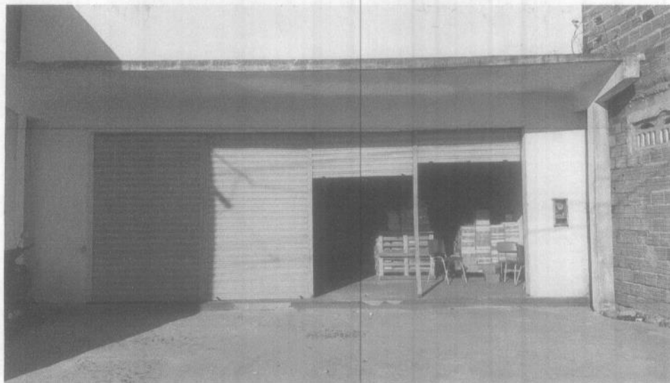
Fachada Fonte: Acervo Técnico (2021)
